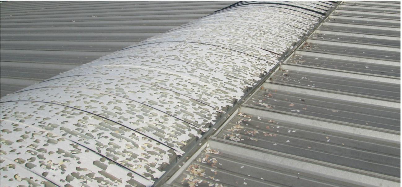
Häufige Gewitter, plötzlicher Starkregen, orkanartige Sturmböen, extremer Hagel – die Folgen des Klimawandels sind in Mitteleuropa deutlich spürbar. Wind, Niederschläge und vor allem große Hagelkörner setzen den Dachflächen von Gebäuden stark zu. Hitzeperioden mit Temperaturen bis 40 Grad im Schatten sorgen für stark aufgeheizte Innenräume, die das effiziente Arbeiten in Gebäuden mit Oberlichtern erschweren.
