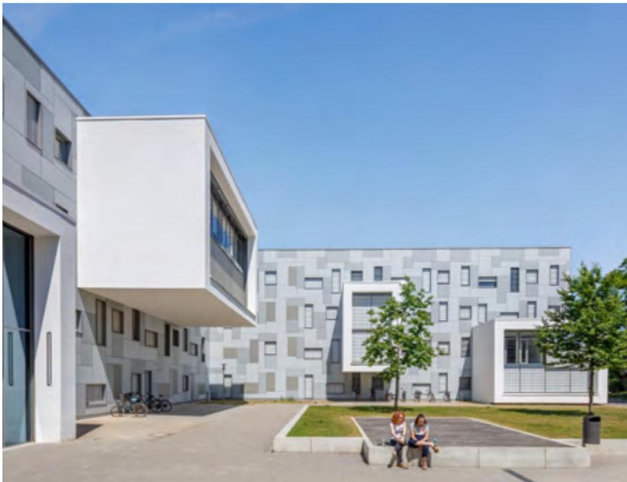
Wie ein Patchwork ist die Fassade aus verschiedenen Formaten und unterschiedlichen Grautönen zusammengesetzt. Auch die Fenster sind – ob stehend oder liegend – scheinbar frei in der Gebäudehülle aus Faserzement angeordnet. 2015 wurde das Lern- und Studiengebäude mit einer Anerkennung beim BDA Preis Niedersachsen geehrt.
