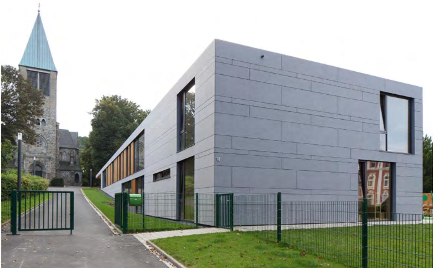
Die grauen Faserzementtafeln der Außenhaut nehmen farblich Bezug auf die mit Schiefer eingedeckten Häuser in der Umgebung. Der Baukörper präsentiert sich durch seine einfache Form sowie durch die klare Strukturierung mit den länglichen, zueinander versetzt angeordneten und unterschiedlich großen Faserzementtafeln modern und eigenständig.
