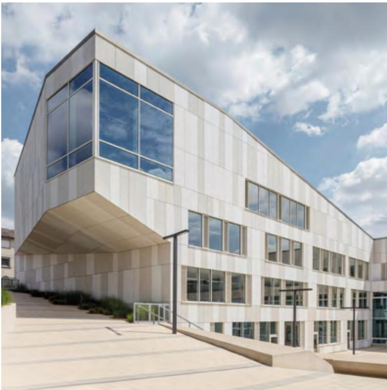
Mit EQUITONE Faserzementtafeln in zwei verschiedenen Farbtönen und unterschiedlichen Formaten bietet die Fachhochschule ein abwechslungsreiches Fassadenbild. So auch an der Deckenuntersicht der auskragenden Stirnseite des Gebäudes.
