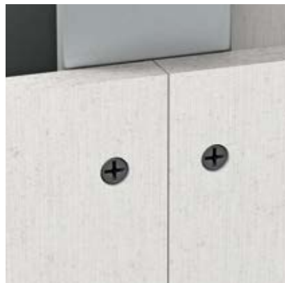
Plattenstoß dicht gestoßen – Fugenbreite: \leq 1 \text{ mm}
