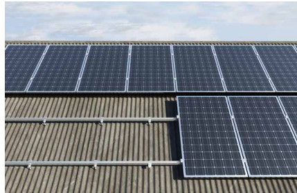
Steildach mit Wellblecheindeckung
