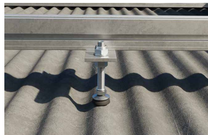
Befestigung an Faserzementplatten
