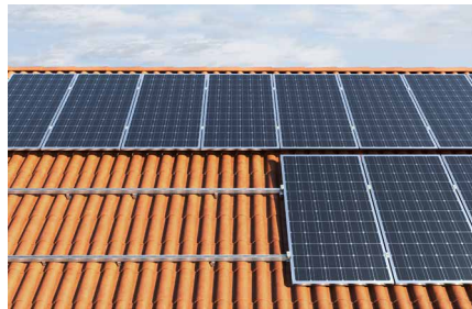
Steildach mit Ziegel-Eindeckung
