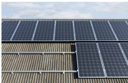
Steildach mit Wellblecheindeckung
