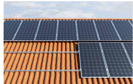
Steildach mit Ziegel-Eindeckung
