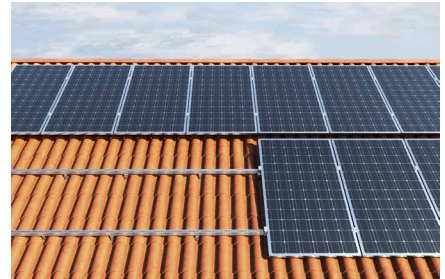
Steildach mit Ziegel-Eindeckung
