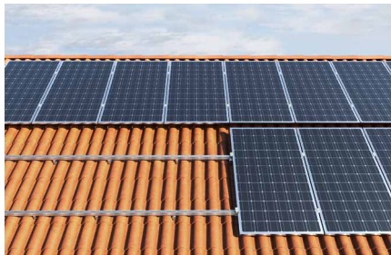
Steildach mit Ziegel-Eindeckung
