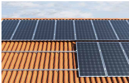
Steildach mit Ziegel-Eindeckung
