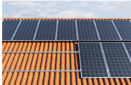
Steildach mit Ziegel-Eindeckung
