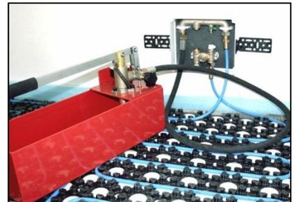
**Bitte beachten Sie, dass ohne Durchführung der Druckprobe eine dauerhafte Funktion des Heizungssystems vom Hersteller nicht gewährleistet werden kann.**
