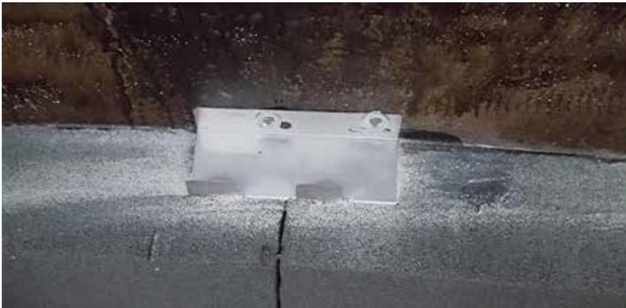
Die Dämmplatten FOAMGLAS® T4+ wurden vollflächig und vollfugig auf den gereinigten und vorangestrichenen Untergrund mittels Bitumenkaltkleber PC® 56 verklebt. Zur mechanischen Befestigung wurden PC® Anker Typ F (4 Stück/m<sup>2</sup>) verwendet.
