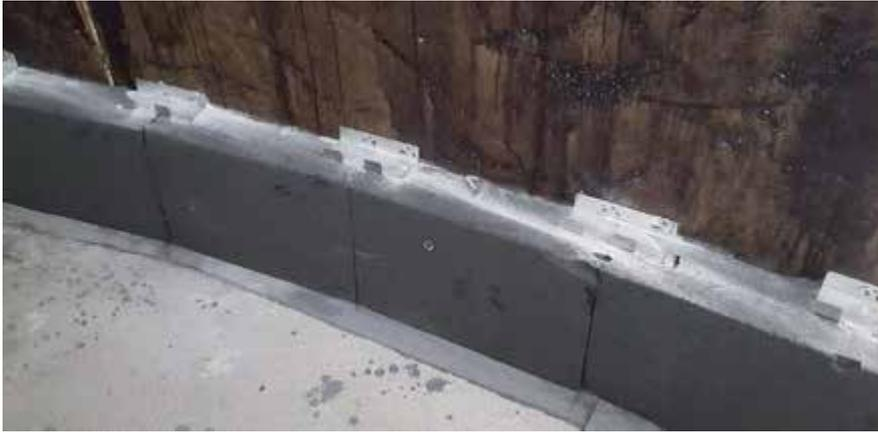
Mit FOAMGLAS® T4+ fiel die Wahl auf eine Dämmung, mit der trotz hartspröder Beschaffenheit Konturen erarbeitet werden können.
