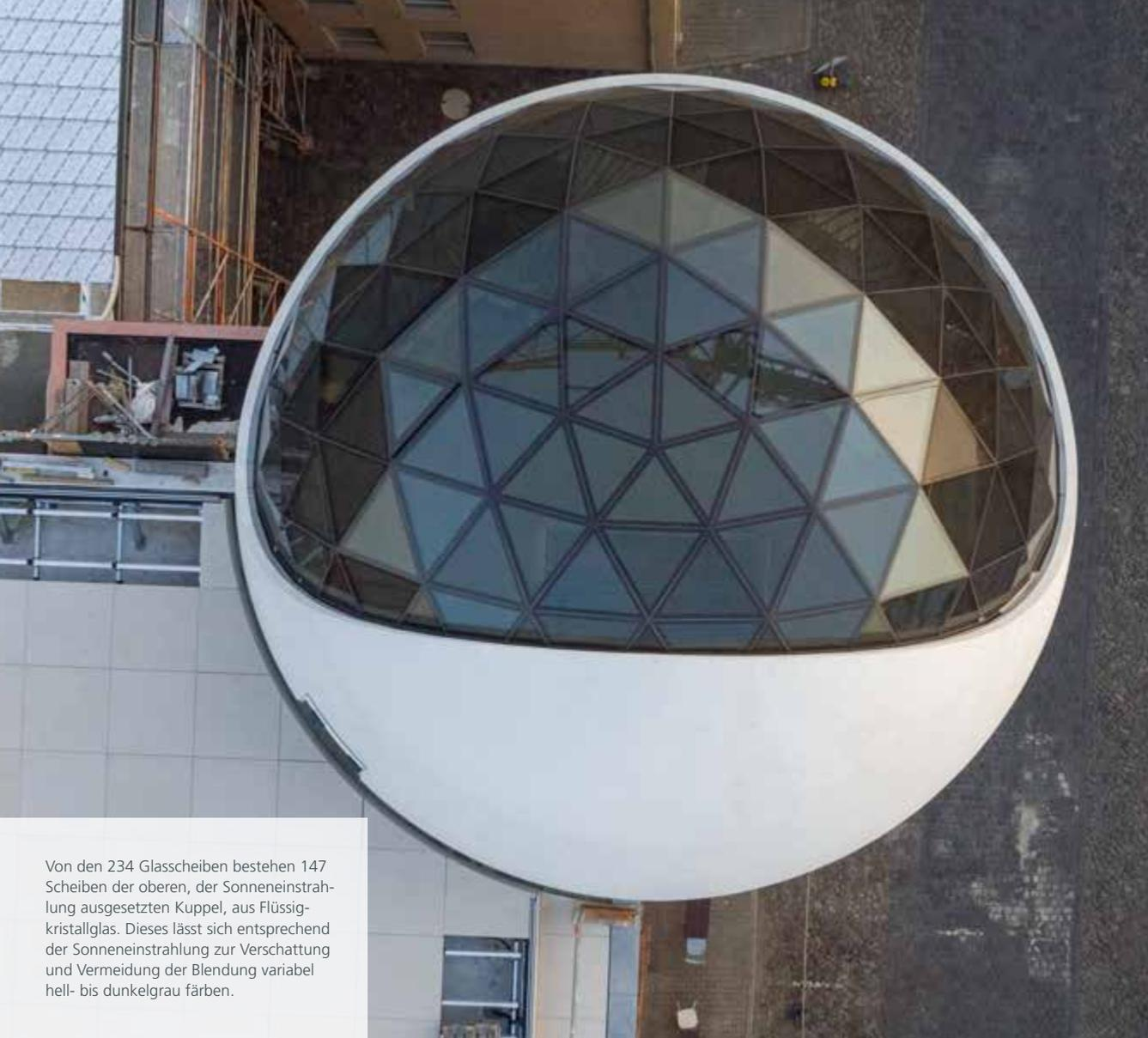
Von den 234 Glasscheiben bestehen 147 Scheiben der oberen, der Sonneneinstrahlung ausgesetzten Kuppel, aus Flüssigkristallglas. Dieses lässt sich entsprechend der Sonneneinstrahlung zur Verschattung und Vermeidung der Blendung variabel hell- bis dunkelgrau färben.
