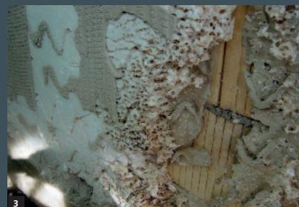
Neben Feuchtigkeit, Spritzwasser und Salzausblühungen kann der Sockelbereich – je nach Bausystem – auch durch biologische Gebäudeschädlinge angegriffen werden. Das reicht von Einnistung oder Zerstörung durch Nager bis hin zu Durchwurzelung und Materialabbau durch Insekten.
