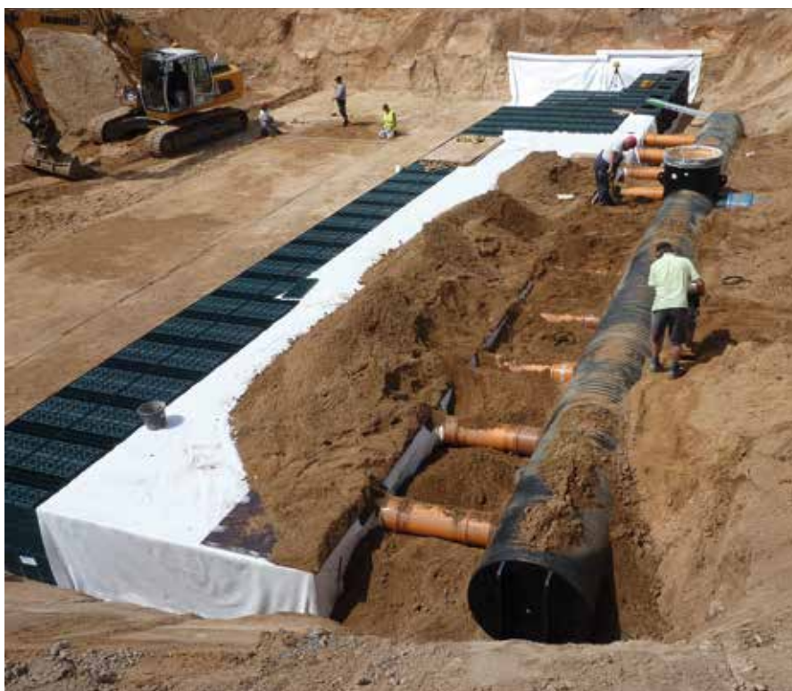
Zweilagige Rigofill-Füllkörperrigole mit Zulaufverteilung
