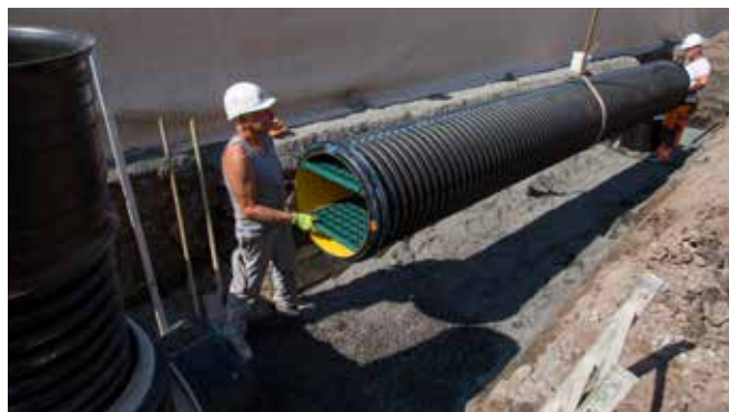
Einbau des Sedimentationsrohres
