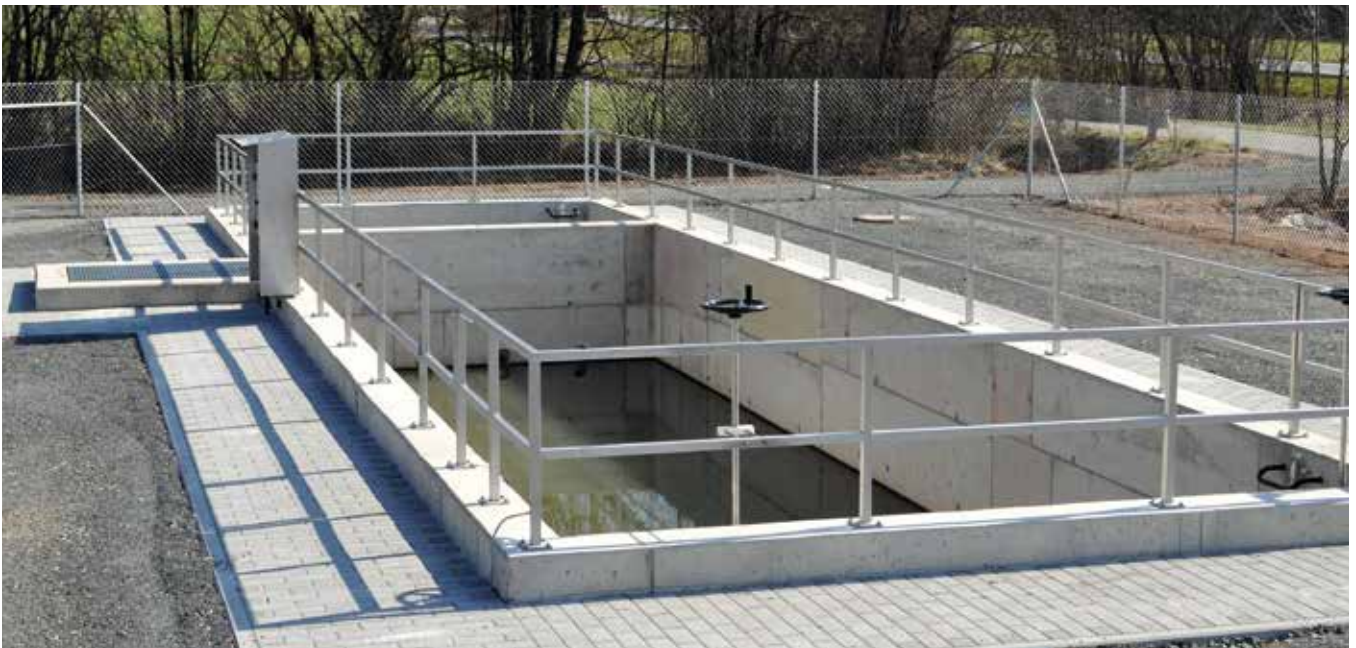
Regenklärbecken in Betonbauweise
