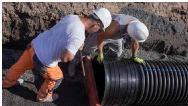
Montage des Sedimentationsrohres
