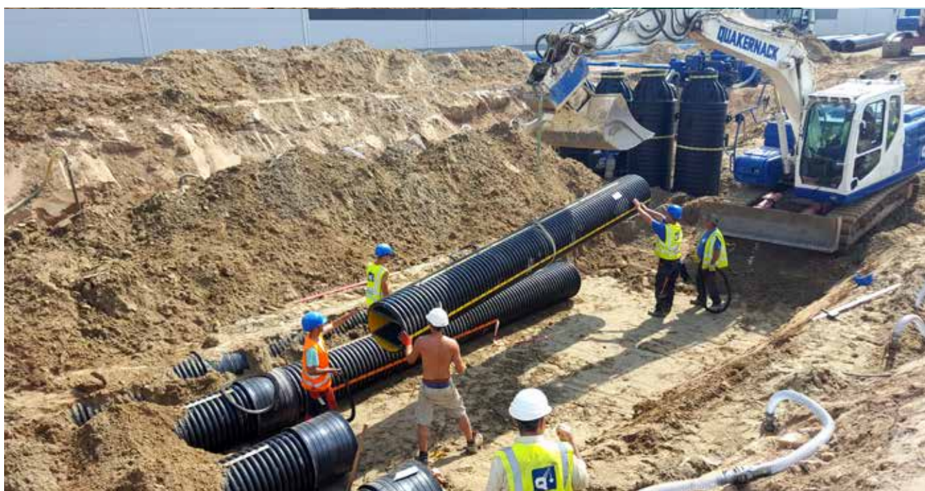
Montage des Sedimentationsrohres
