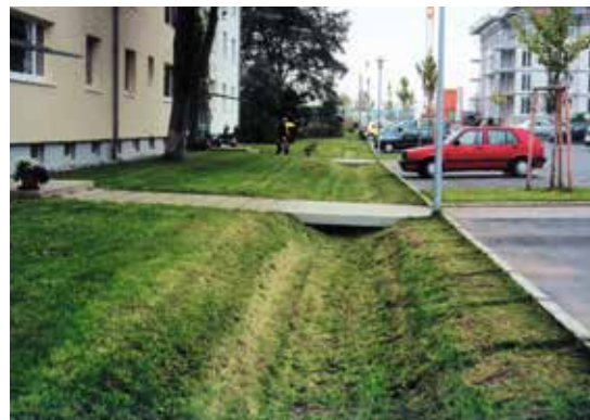
Muldenrigolen-Versickerung in einem Erschließungsgebiet
