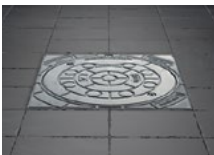
quadratische Schachtabdeckung (Guss), Klasse B 125, 35 x 35 cm
