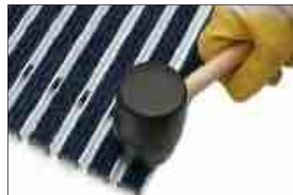
Neue Ripsstreifen mit Selbstklebeband in das Aluprofil einkleben und ggf. mit einem Gummihammer den Klebprozess verstärken.
