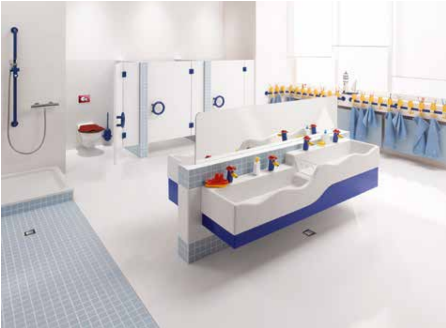
Abbildung 15: Beispiel eines Sanitärraums in einem Kindergarten
