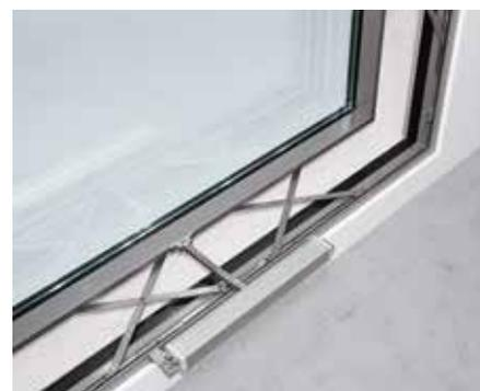
Die Fensterfläche wird parallel zur Glasfassade ausgestellt
