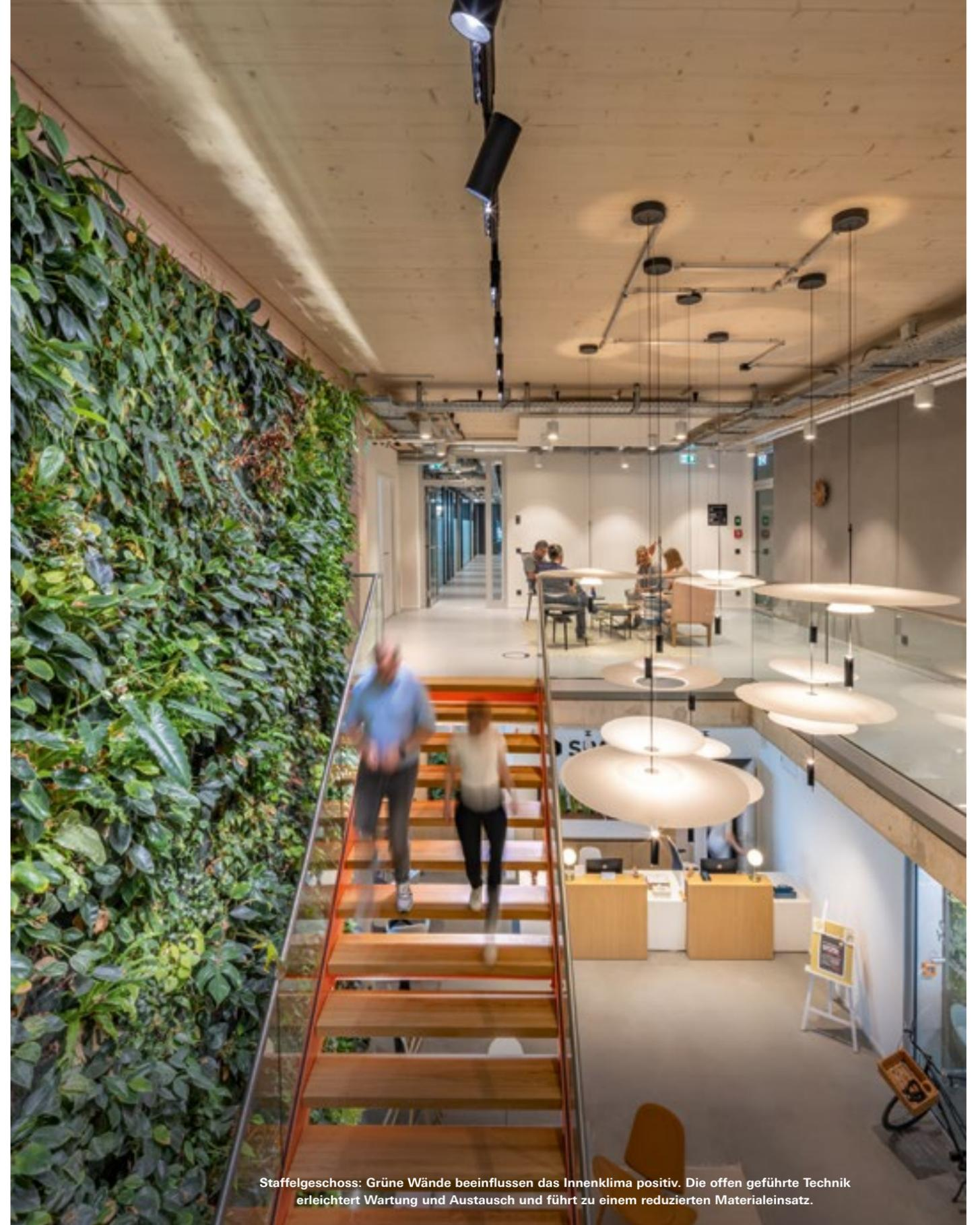
Staffelgeschoss: Grüne Wände beeinflussen das Innenklima positiv. Die offen geführte Technik erleichtert Wartung und Austausch und führt zu einem reduzierten Materialeinsatz.
