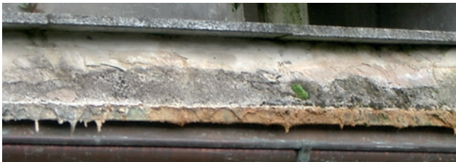
Das Ergebnis ungeschützter Estrichschichten: Schadhafte Balkonränder mit Kalkfahnen.
