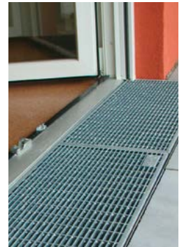
Spezialroste für barrierefreie Übergänge
