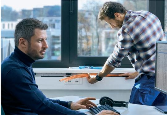
Die neuen Seitenoberteile lassen sich verwindungsfrei abziehen und ebenso einfach wieder aufrasten, selbst unter Wandvorsprüngen und Fensterbänken. Damit ist eine Nachinstallatilon im Laufenden Betrieb möglich.
