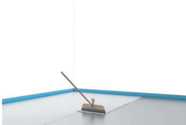
3.1.1. Aufbringen der Bodenverlaufmasse mittels Zahnrakel
