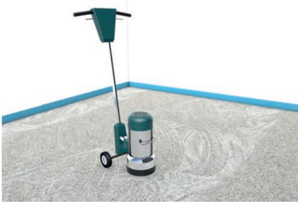
1.2 Untergrund zur Beschichtung vorbereiten mittels Diamantschleifer oder Kugelstrahlgerät
