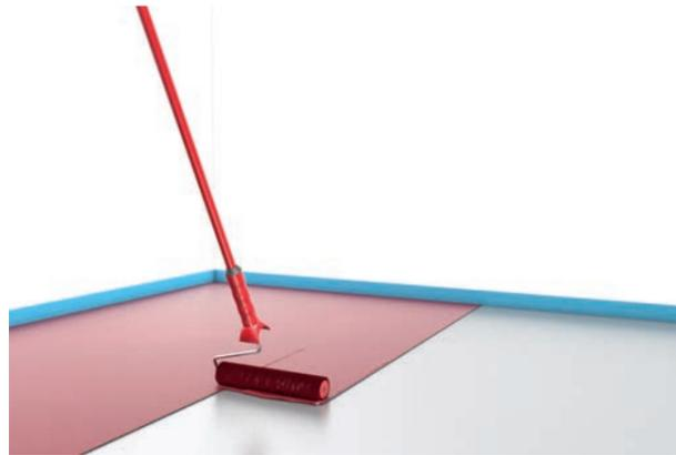
3.1.2. Aufbringen der Rollbeschichtung mittels Kurzflorwalze
