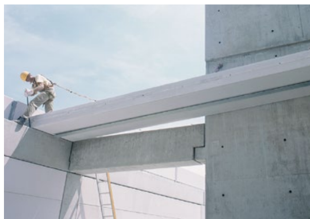
Montage eines Hebel Brandsicherheitsdachs
