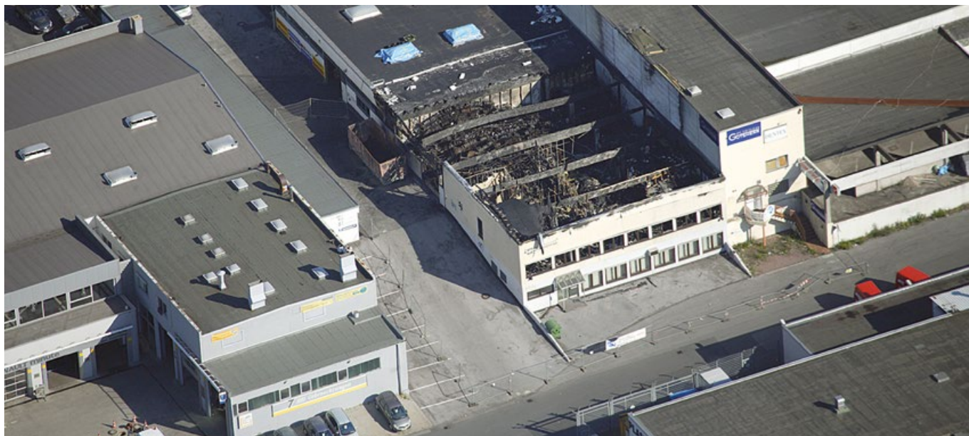
Brandwände aus Porenbeton verhinderten hier den Übergriff des Feuers auf benachbarte Gebäudeabschnitte.
