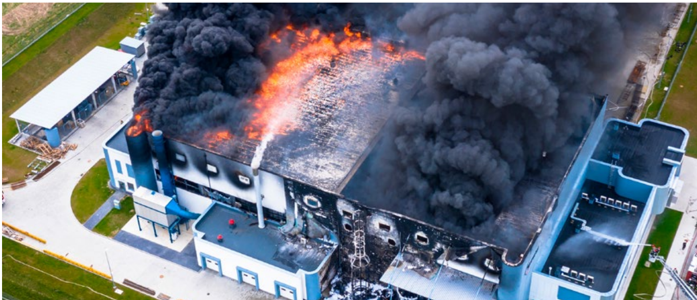
Totalschaden durch ein brennendes Dach
