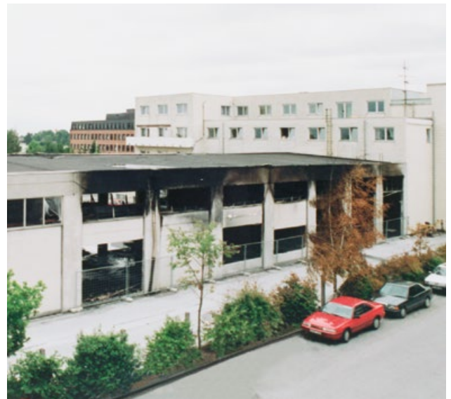
Mit Brandwänden aus Porenbeton konnte hier das Feuer auf einen abgetrennten Gebäudeabschnitt begrenzt werden. Weder der Kopfbau noch die restlichen Hallenabschnitte wurden beschädigt. Ein feuerbeständiges Dach trug dazu bei, dass sich der Brand nicht weiter ausbreiten konnte. (Foto: Versicherungskammer Bayern)
