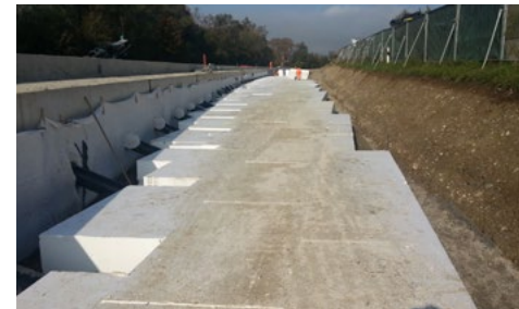
Dammsicherung in Konstanz
