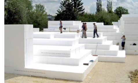
Straßenbauobjekt Bundesstraße 33, Blaustein bei Ulm
