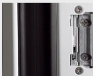
Beim **elektrischen Türöffner/Türschliesser ETOE** (Normalfunktion) ist die Tür nur während der Kontaktgabe (Taste gedrückt) zu öffnen (kein Dauerkontakt).
