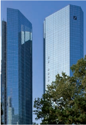
Als weltweit erstes modernisiertes Hochhaus werden die neuen Deutsche-Bank-Türme in Frankfurt mit einer LEED Platin Zertifizierung ausgezeichnet. Als Teil des komplett neuen Klimakonzeptes dieser Bestandsimmobilie wurde auch die Fassade ausgetauscht. Jetzt besticht sie mit einem durchschnittlichen U_{wv} von 0,6 \text{ W/(m}^2\text{K)} mit einem hocheffizienten Dreifach-Sonnenschutzglas ipasol Sondertyp.
