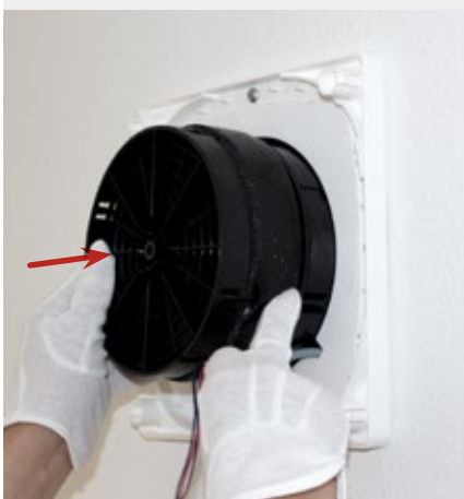
Einschieben von inVENTron®: Leitwerke und Xenion-Ventilator
