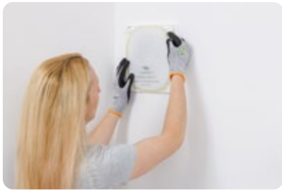
Filter an der Lasche rechts oben von der Grundplatte lösen
