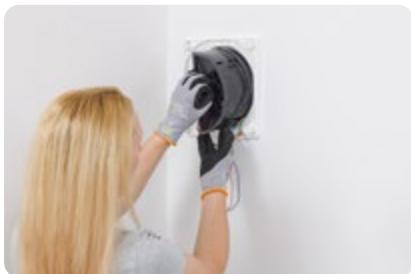
Ventilatoreinheit aus der Wandeinbauhülse entnehmen
