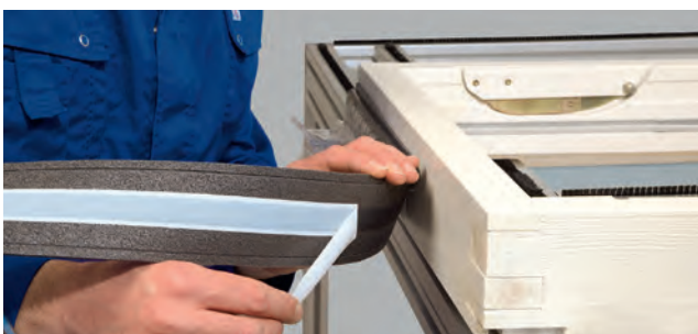
Einbaubeispiel (1-BT): Holzfenstermontage
