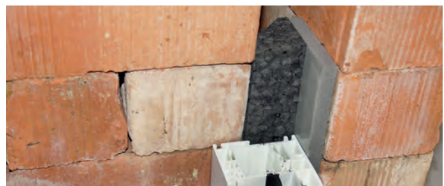
Einbaubeispiel: ISO-BLOCO FILLER
