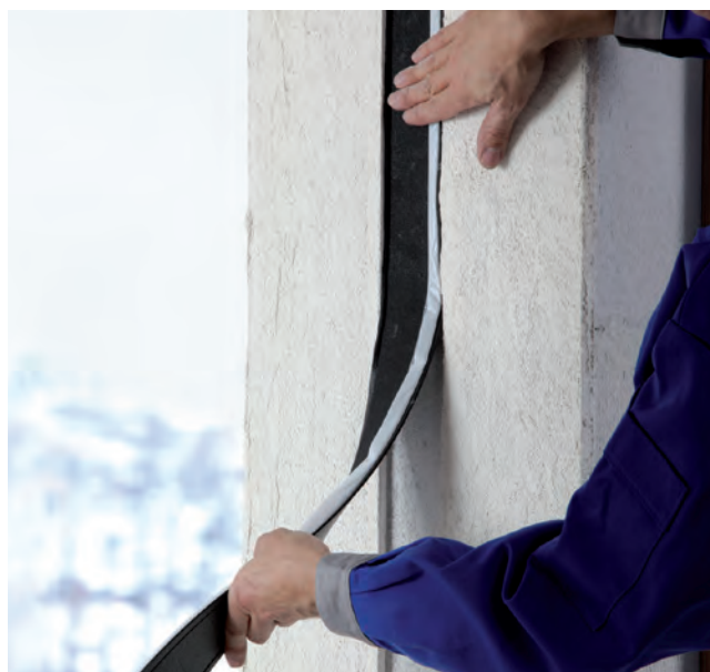
Einbaubeispiel: ISO-BLOCO RENO
