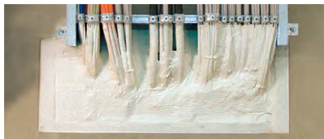
Einbaubeispiel: ISO-FLAME PLATTE S 90
