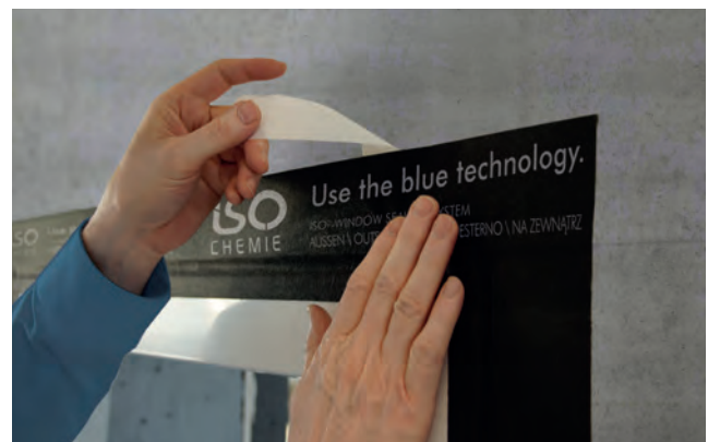
Einbaubeispiel: ISO-CONNECT OUTSIDE CL
