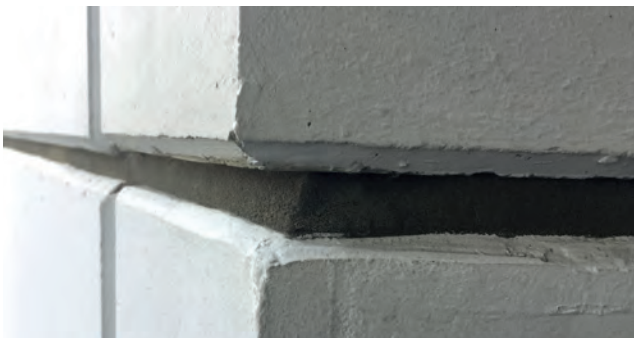
Einbaubeispiel: ISO-BLOCO AIR
