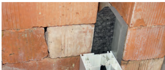
Einbaubeispiel: ISO-BLOCO FILLER
