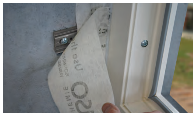
Einbaubeispiel: ISO-CONNECT VARIO SD „PADS“
