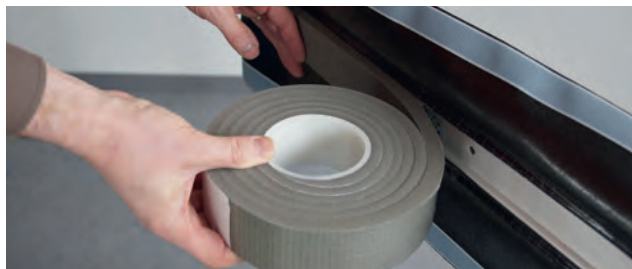
Einbaubeispiel: ISO-BLOCO HF
