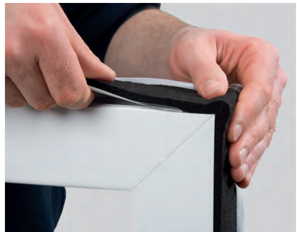
Einbaubeispiel: ISO-BLOCO ONE
