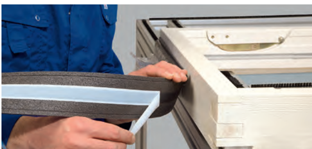
Einbaubeispiel (1-BT): Holzfenstermontage
