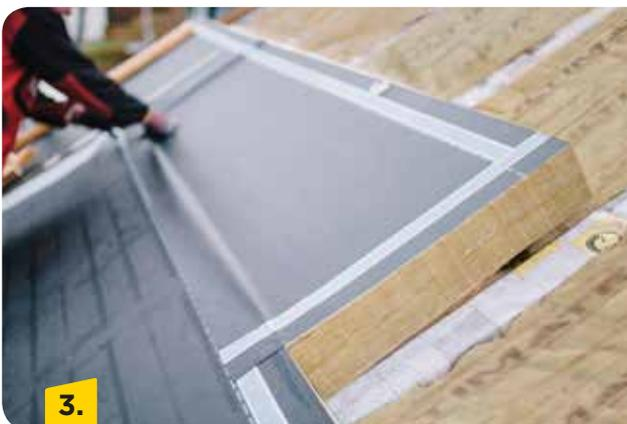
ULTIMATE AP SupraPlus-031 über den Sparren und vollständig gefülltem Gefach verlegen. Bis maximal 85 cm Sparrenabstand auf oberflächenbündigem Dämmstoff ohne Schalung verlegbar (Alternativ ULTIMATE AP Supra-031 und Integra ZUB verlegen).
