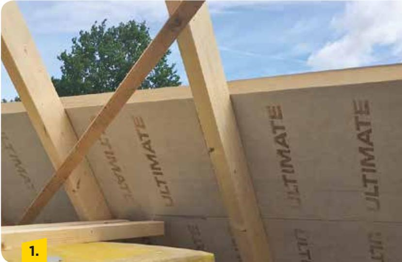
Von außen auf dem Dach ULTIMATE AP SupraPlus-031 Dämmplatten über die Sparren verlegen. Die Platten werden stumpf gestoßen.
