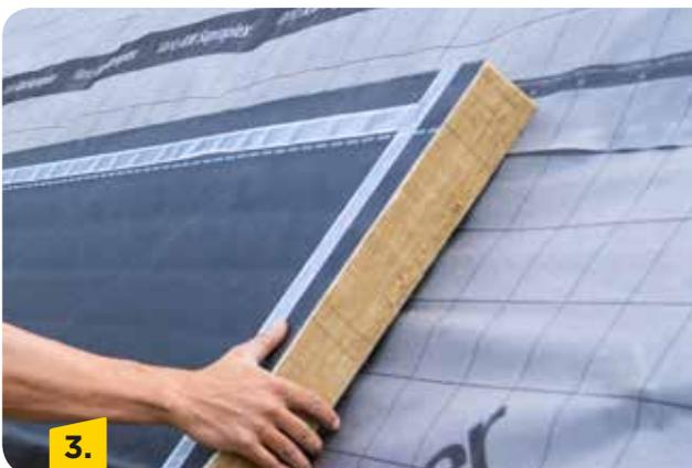
ULTIMATE AP SupraPlus-031 Dämmplatten auf Vario® KM Supraplex-SKS verlegen. Die Platten werden stumpf gestoßen. Dabei ist keine Schalung als Unterlage notwendig.
