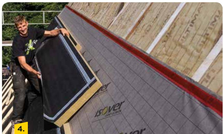
Die ULTIMATE AP SupraPlus-031 Dämmplatten auf der Klimamembran Vario® KM Supraplex-SKS verlegen. Die Platten werden stumpf gestoßen. Bis maximal 85 cm Sparrenabstand auf oberflächenbündigem Dämmstoff ohne Schalung verlegbar. (Alternativ ULTIMATE AP Supra-031 und Integra ZUB verlegen.)
