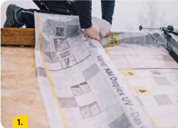
Integra UMP-032 als Nagelschutzplatte in die Gefache einlegen. Vario® KM Duplex UV schlaufenförmig um die Sparren verlegen. Die Klimamembran mit Vario® ZSL Sanierungsleisten sauber am Sparregrund fixieren. Dies verhindert Hohlräume, die mit warmer Raumluft hinterströmt werden könnten. Alternativ zur Vario® KM Duplex UV kann auch die Vario® Xtra Safe verlegt werden.
