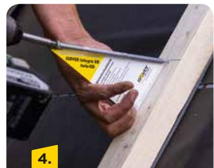
Mittig auf den Nageldichtbändern die Konterlatten mittels Integra AB twin-UD Spezialbefestiger aufschrauben. Keinesfalls Standardschrauben verwenden!
