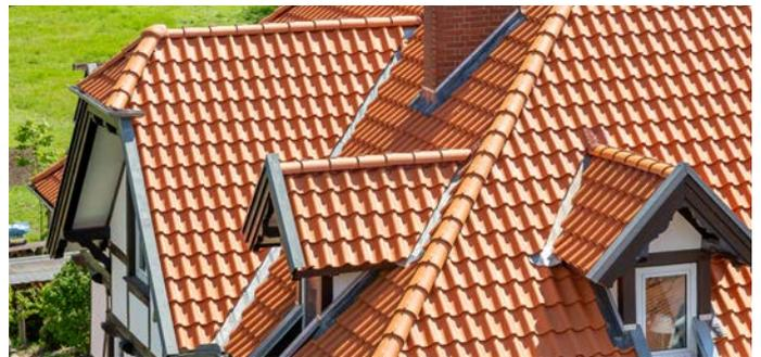
Besonderes Augenmerk bei der Sanierung lag auf dem Dach, das laut Vorgaben der Denkmalschutzbehörde optisch so nah und auch so natürlich wie möglich an den Ursprungszustand erinnern sollte. Aus diesem Grund entschied sich der Bauherr für den Hohlalzziegel Z5, der in der Ausführung Geradschnitt der vorherigen Eindeckung mit historischen Hohlpfannen ähnelt. Zusätzlich passen die hellen, naturroten Dachziegel gut zum Objekt und Ortsbild – eben so, als würden sie schon Jahrhunderte dahin gehören.
