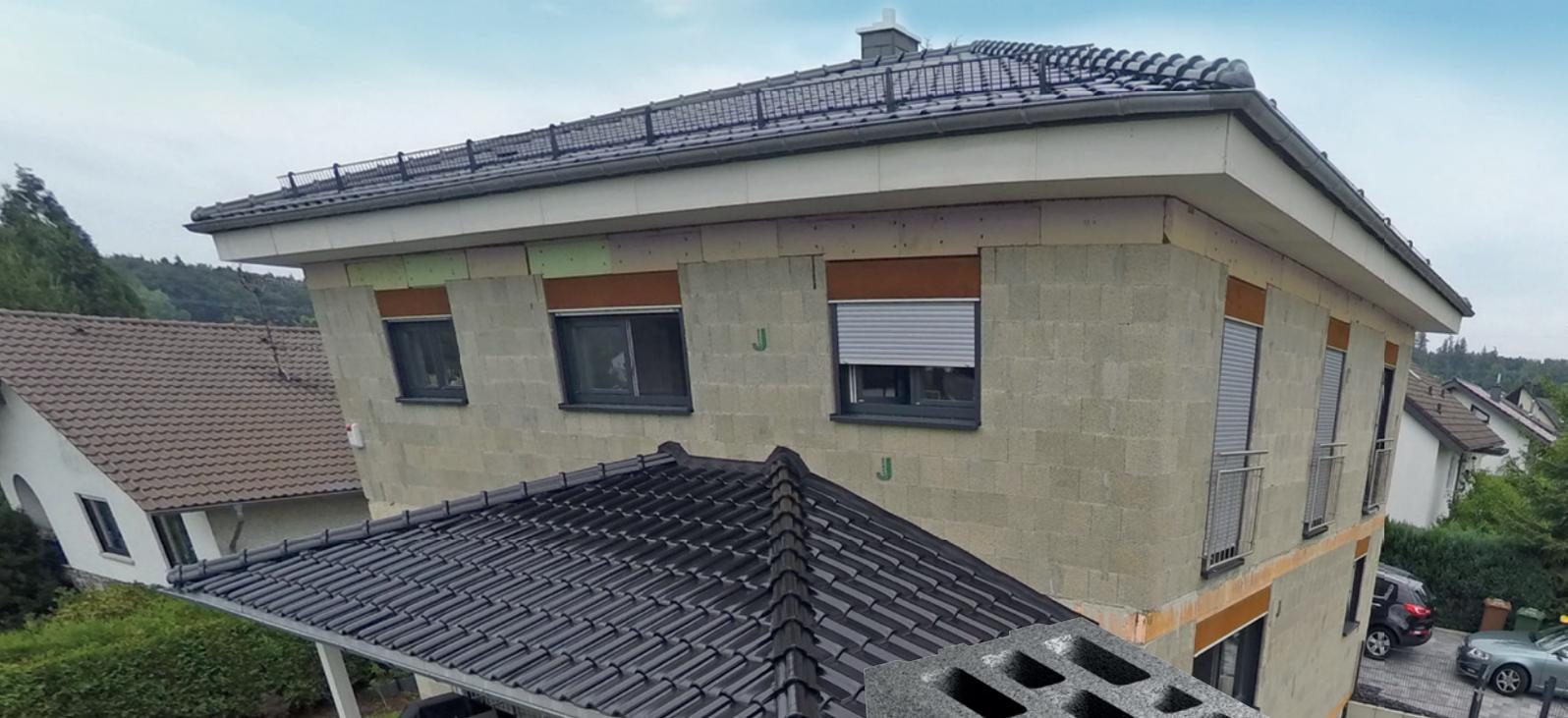
Wir fertigen unsere **HOHLBLÖCKE** für die Verarbeitung mit JASTO Dünnbettmörtel (Fugendicke ca. 1 mm) aus Leichtbeton in verschiedenen Rohdichte- und Festigkeitsklassen in allen gängigen Mauerwerksdicken. Das macht diese Steine zum „Allround-Talent“, das für viele Einsatzgebiete verwendet werden kann. Ob als Außenmauerwerk mit zusätzlicher Wärmedämmung (Wärmedämmverbundsystem WDVS) oder als Innenmauerwerk für tragende und nicht tragende Wände.
