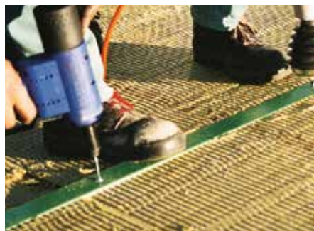
Befestigen der Schiene mit Spreiznieten
