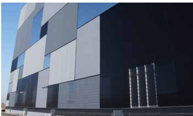
Richtungsunabhängige Montage der Kalzip FC Paneele.
