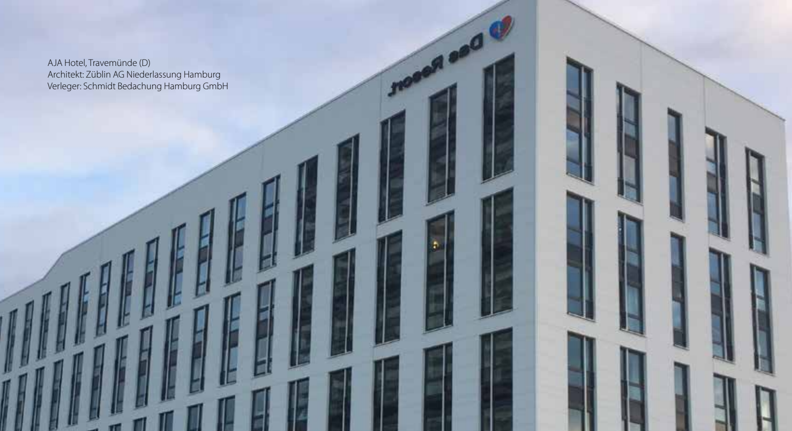
Hybrid FC Paneel auf Sandwichelement: horizontal, parallel
