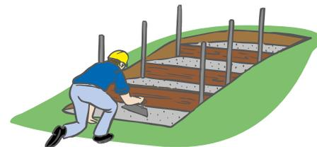
Wenn die Form ausgehärtet ist, die Schalung wieder entfernen. Auf die vorgeformten Stufen 2–3 Querstreifen aus Mörtel (1–2 cm dick, der Mörtelgruppe MG III) zur Verklebung der Stufe auftragen.
