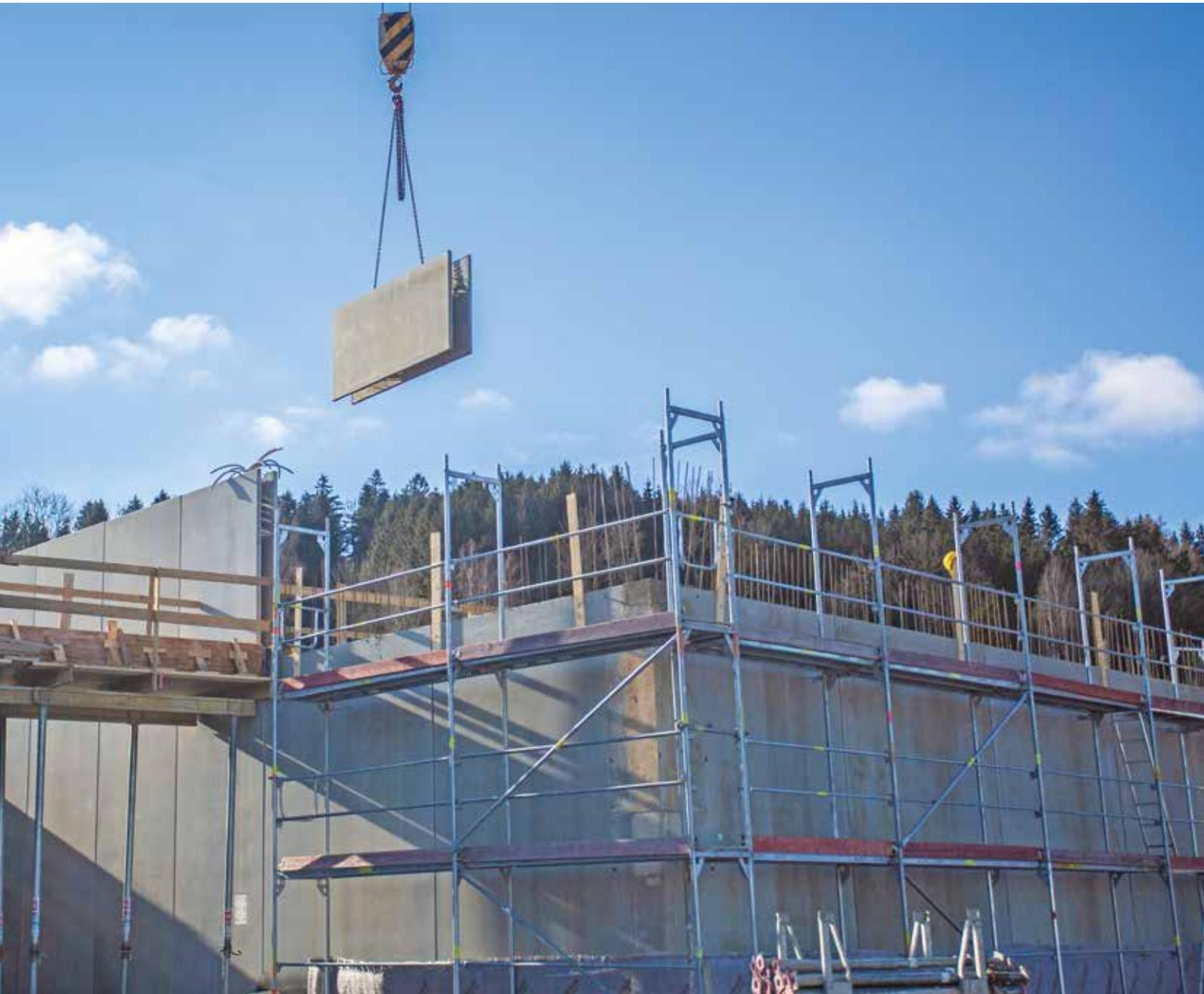
*Doppelwände: innovative Systembauteile aus den Karl Bachl Betonwerken*
