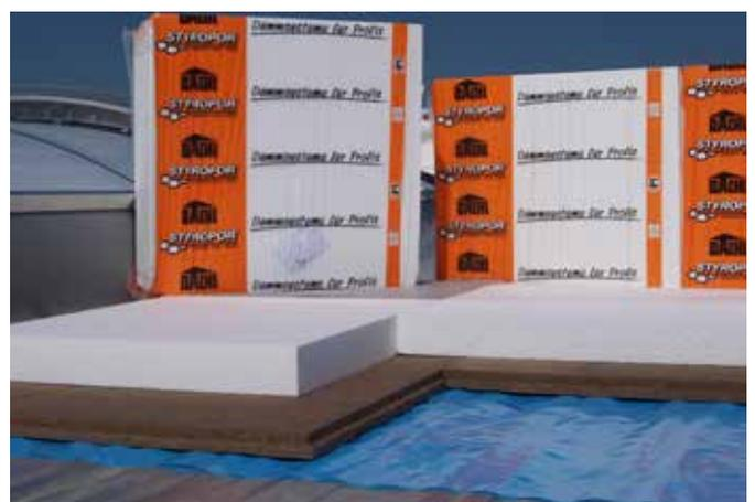
*Systematischer Aufbau einer Flachdachdämmung*
