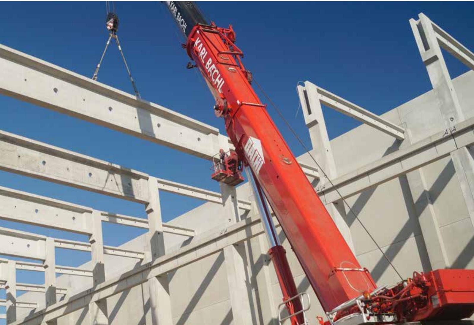
Ein professionelles Team für große Projekte: Eine moderne und nachhaltige Bauweise ist ohne konstruktive Fertigteile aus Stahl- und Spannbeton heute kaum mehr denkbar. Hochwertig und nach jeweiliger Anforderung produziert, beschleunigen diese jedes Bauvorhaben und sind wirtschaftlicher als aufwendige Schalungsarbeiten vor Ort.
