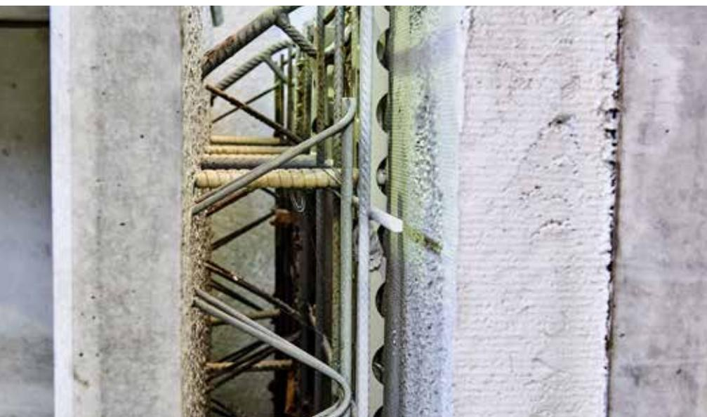
*Doppelwand mit integrierter Wärmedämmung als Thermowand*
