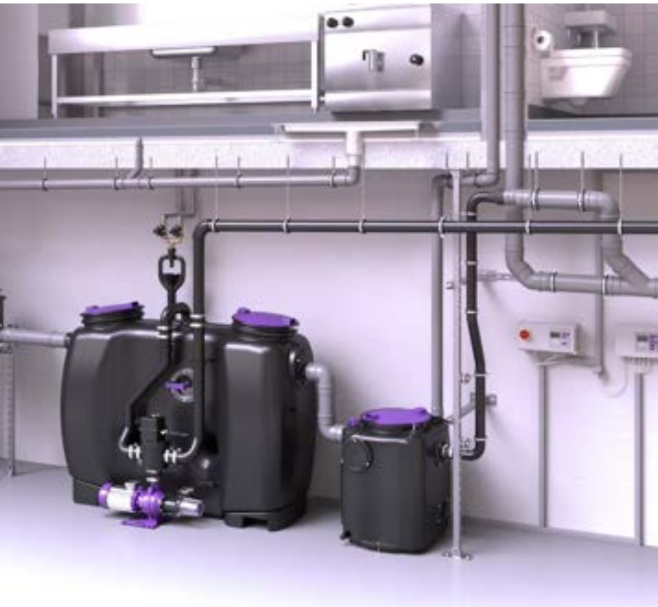
Beispiel einer Fettabscheideanlage mit nachgeschalteter Hebeanlage
