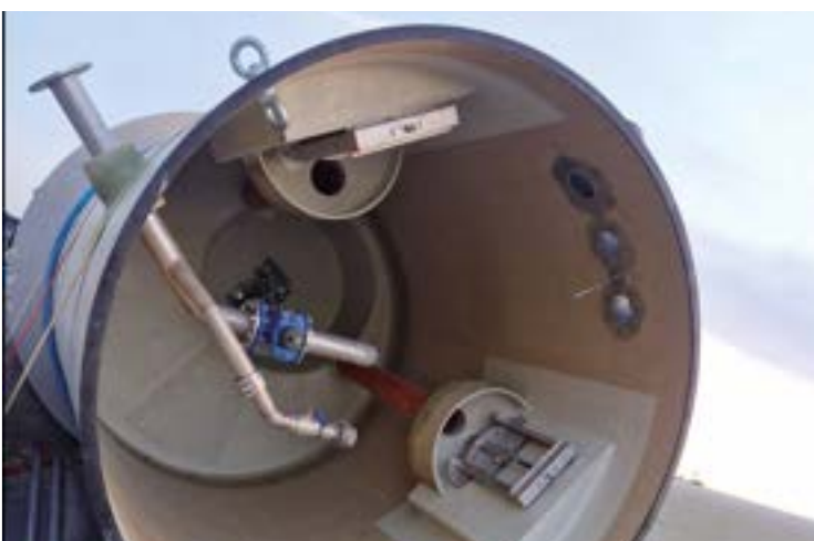
Funktionsschächte aus Glasfaserverstärktem Kunststoff (GFK)
