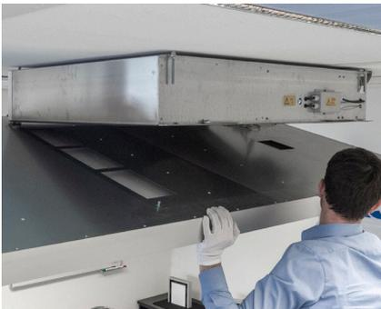
Abbildung 4: Öffnen des Akustiksegels
