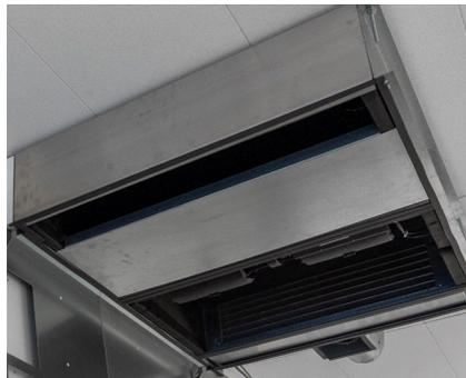
Abbildung 5: Revisionsöffnung für Ventilator und Wärmeübertrager.
