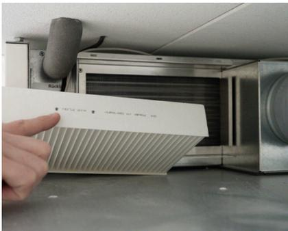
Abbildung 1: Einsetzen der Filterzelle (als Ersatzteil erhältlich)
