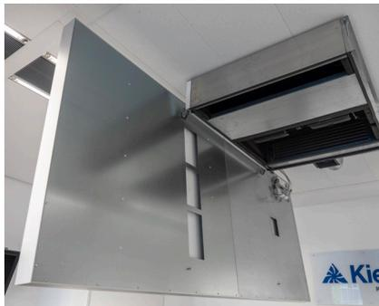
Abbildung 2: Schwenkbares Akustiksegel gewährleistet leicht zugängliche Wartung und Inspektion des Geräts (VDI 6022).
