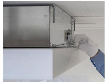
Abbildung 3: Lösen der Mutter (M8).
