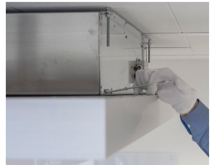
Abbildung 3: Lösen der Mutter (M8).
