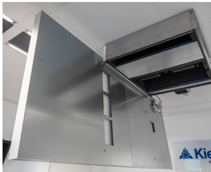
Abbildung 2: Schwenkbares Lichtsegel gewährleistet leicht zugängliche Wartung und Inspektion des Geräts (VDI 6022).
