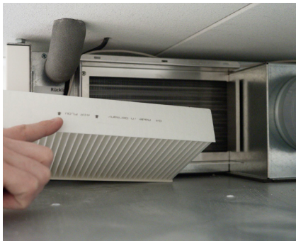
Abbildung 1: Einsetzen der Filterzelle (als Ersatzteil erhältlich)
