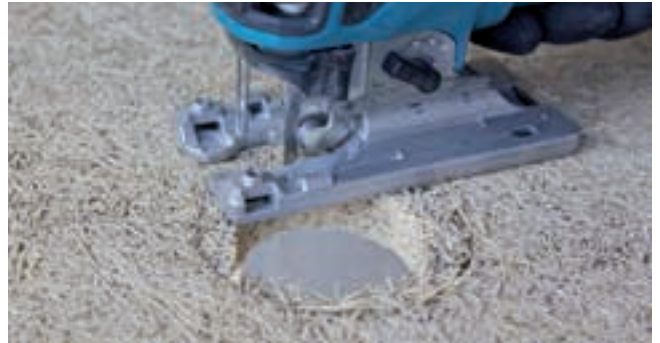
Ausschneiden einer Öffnung mittels Stichsäge. Die Sichtseite der Platte ist unten.
