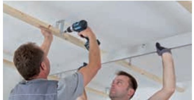
Ausfluchten der Latten mittels Wasserwaage oder Lasergerät und Befestigung der Latte am Abhänger z.B. Schnellabhänger mit je 2 Schrauben pro Seite.
