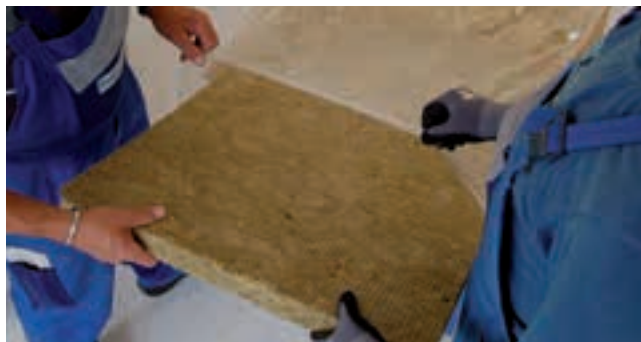
Einschieben der Akustikauflage.
