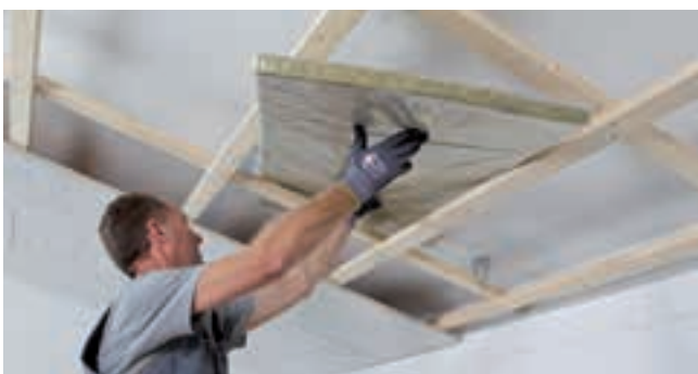
Einlegen von HERADESIGN® Akustikauflage oder anderen akustisch wirksamen Auflagen, Zug um Zug mit der Montage der HERADESIGN® Akustikplatten. Absorberplatten, die zwischen die Holzlatte geklemmt werden, werden auf Maß geschnitten.
