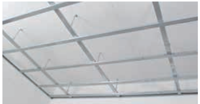
Fertiger Deckenrost.
