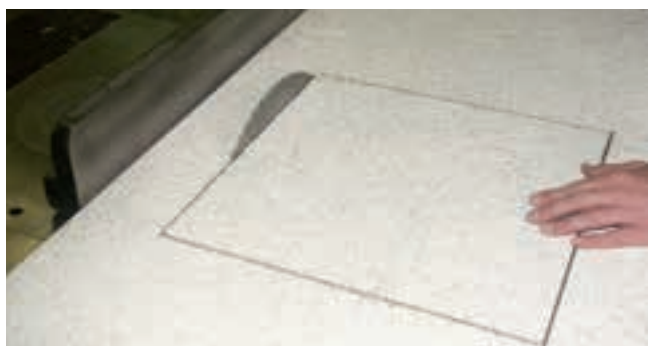
Ausschneiden der Öffnung/Deckplatte von der Plattenrückseite aus.
