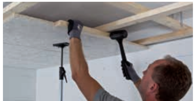
Eventuelle Plattenfugen mit Verlegeholz und Hammer pressgestoßen schließen. Verarbeitung der Akustikplatten nur mit sauberen Händen ( die Verwendung von sauberen Handschuhen wird empfohlen) und sauberem Werkzeug.
