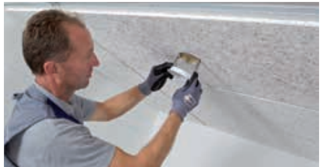
Einsetzen des Rahmenteiles eines Spotlights.
