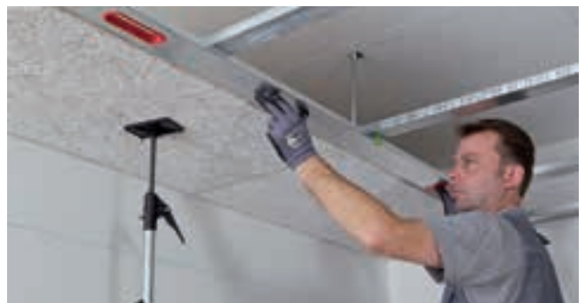
Ausfluchten der Plattenreihen mit Verlegelatte. Plattenstöße müssen mittig unter dem Profil angeordnet sein. Keine freien, schwebenden Plattenstöße zulässig! Die auf der Plattenrückseite gekennzeichnete Verlegerichtung ist bei der Verlegung von quadratischen Platten zu beachten.
