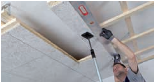
Ausfluchten der Plattenreihen mit Verlegetlatte. Plattenstöße müssen mittig unter dem Profil angeordnet sein. Keine freien Plattenstöße zulässig.
