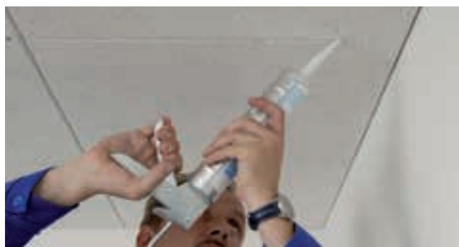
Fugen können bei HERADESIGN® micro Akustikplatten mit Knauf Arcylat Dichtungsmasse ausgefügt werden. Überstreichbar mit Silikatfarbe.
