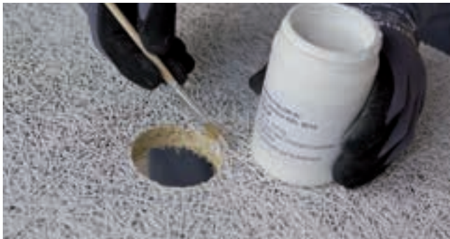
Schnittträger mit Farbe abdecken, wenn diese nicht durch eine Blende verdeckt sind.
