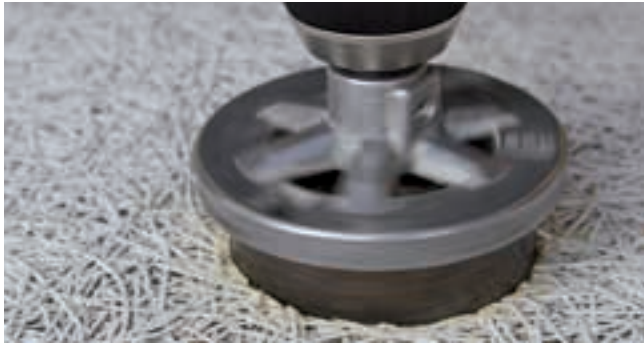
Bohren einer Kreisöffnung für Spotlights. Die Sichtseite der Platten ist oben.
