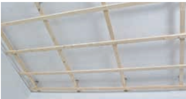
Montage der Grund- und Traglattung. Max Abstände siehe Abstände laut Tabelle „Maximale Abstände der Unterkonstruktion“ für Schraubmontage auf Holzlatte und Detail Anschluss Grundlatte/Traglatte
