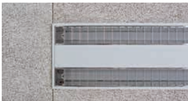
Fertig eingebaute Rasterleuchte. Plattenfuge wird durch den Blendrahmen abgedeckt.
