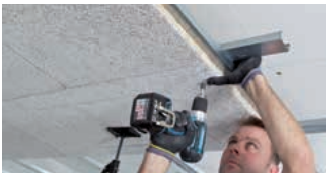
Montage der Akustikplatten mittels Hilfsstütze. Platte während des Schraubens mit dem Handballen an das Profil anpressen. Es darf kein Spalt zwischen Akustikplatte und Profil entstehen. Beginn der Plattenmontage von der Raummitte aus. Verarbeitung der Akustikplatten nur mit sauberen Händen (die Verwendung von sauberen Handschuhen wird empfohlen) und sauberem Werkzeug.
