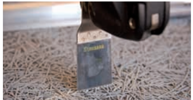
Ausschneiden von Öffnungen durch „Supercutter“
