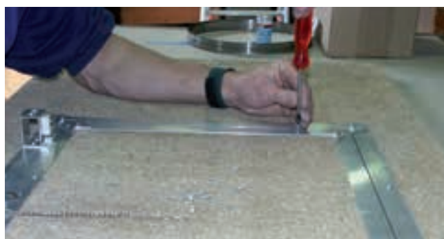
Anschrauben der Deckplatte mit min. 2 x 4 Stück Schrauben 4,5 x 20 mm pro Rahmen 40 x 40 bzw. 2 x 6 Stück bei 60 x 40 cm und Heraklith-BM PU oder Polymerkleber am inneren Rahmen.
