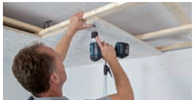
Montage der Akustikplatten mittels Hilfsstütze. Platte während des Schraubens mit dem Handballen an die Latte anpressen. Es darf kein Spalt zwischen Platte und Holzlatte entstehen. Bei größeren Decken Beginn der Plattenmontage von der Raummitte aus. Verlegerichtung bei quadratischen Platten beachten!
