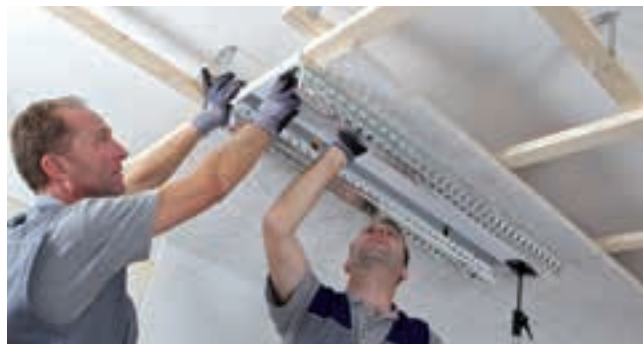
Alternativ: Befestigung der Deckenleuchte mittels Schrauben in die seitlichen Holzleisten, CD-Profilen oder Direktbefestigung in der Decke.
