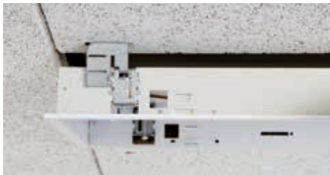
Einhängen der Deckenleuchte. Befestigung mittels mitgelieferter Seitenflügel an T-Profile, CD-Profile oder Holzleisten. Einbauhöhe der Leuchte auf die vorhandene Abhängenhöhe abstimmen.
