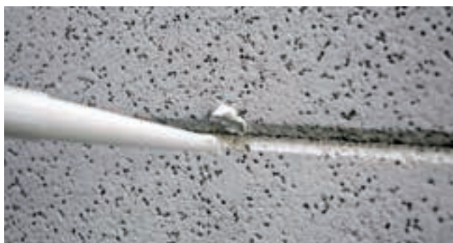
Sanierung kleiner Fehlstellen bei HERADESIGN® micro oder HERADESIGN® plano Akustikplatten: Die Fehlstelle/Kantenausbruch wird mit Acrylat oder Holzkitt ausgefüllt, mit einer Spachtel abgezogen und nach dem Austrocknen mit Plattenfarbe abgedeckt.
