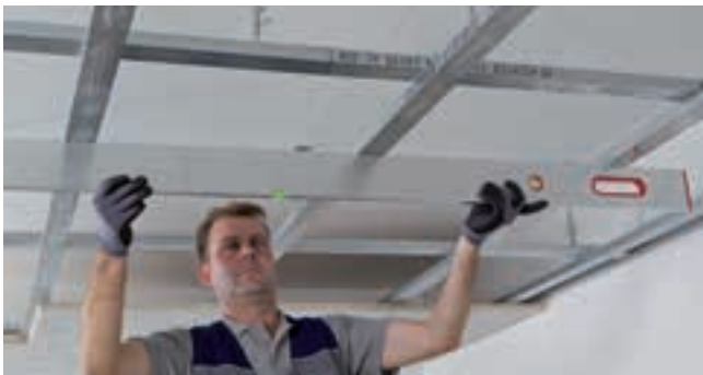
Ausfluchten der CD-Profile mittels Wasserwaage oder Lasergerät.
