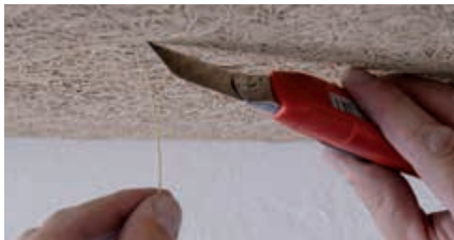
Herunterhängende Fasern: Einzelne lose Fasern mit einem Messer vorsichtig abtrennen.
