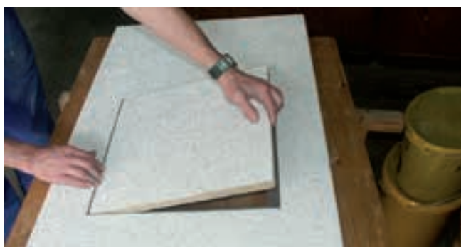
Einlegen der Deckplatte.
