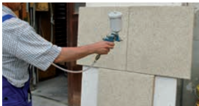
Ein- bzw. Umfärben: Die Farbe wird mit einem Airless-Spritzgerät unter verschiedenen Spritzwinkeln vorsichtig aufgesprüht.
