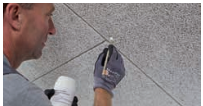
Wenn keine eingefärbten Schrauben verwendet werden überstreichen der Schraubenköpfe mit mitgelieferter oder gleichwertiger Farbe unter Verwendung eines feinen Pinsels und angepasster Farbmenge. Schraubenköpfe müssen planeben mit der Plattenoberfläche gesetzt werden.
