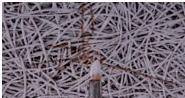
Faserausbrüche: Faserausbrüche mit feinem Pinsel, kurzflorige Malerwalzen oder Airless-Spritzgerät mit mitgelieferter oder gleichwertiger Farbe abdecken.
