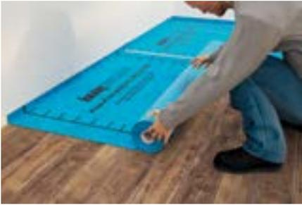
Zunächst wird die Dampfbremsbahn LDS 2 Silk verlegt. Die Überlappungen werden mit dem Haftklebeband LDS Soliplan verklebt. Der Wandanschluss erfolgt mit der LDS Kleberaube.
