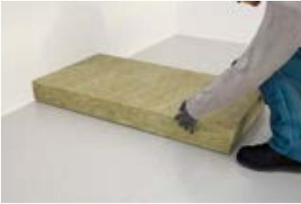
Für die Erstellung der Laufwege wird als erstes die Dachboden-Dämmplatte TPD-L verlegt.
