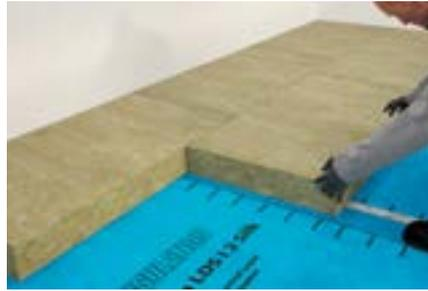
Mit der Verlegung in einer Raumecke beginnen und lose auf der Dampfbremsbahn im Verband verlegen (Versatz  $\geq 10$  cm).
