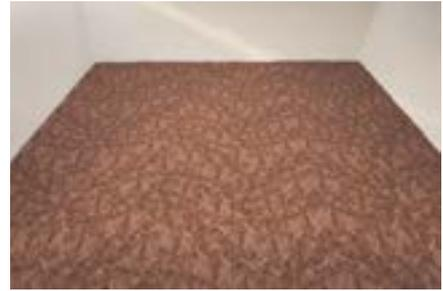
Die gesamte Oberste Geschossdecke ist flächig und ohne Lücken mit dem Dämmstoff zu belegen.
