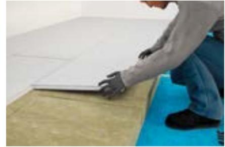
Um die Belastbarkeit zu erhöhen, wird ein Fertigteilstrich (z. B. Knauf Brio 18 oder Knauf TUB) oder eine Spanplatte auf der Dämmung verlegt. Bei der Verlegung des Fertigteilstrichs ist darauf zu achten, dass der Fugenversatz zur Dämmung mind. 100 mm beträgt. (Nicht zur Wohnraumnutzung geeignet)
