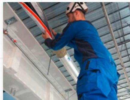
**Schnelle Montage:** Der integrierte Schnellverschluss erleichtert die Arbeit.
