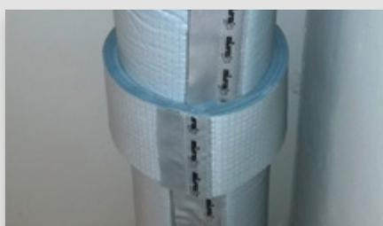
**Praktischer Zusatz:** Dämmung für Muffen und Befestigungsschellen im Bereich innenliegender Regenwasserleitungen. Passgenau zugeschnitten, ermöglichen die neuen schmalen Dämmstreifen durchgängigen Tauwasserschutz.
