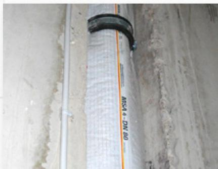
**Ausführung:** Die Dämmschläuche sind in 10 Meter Länge und 4 mm Dicke erhältlich.
