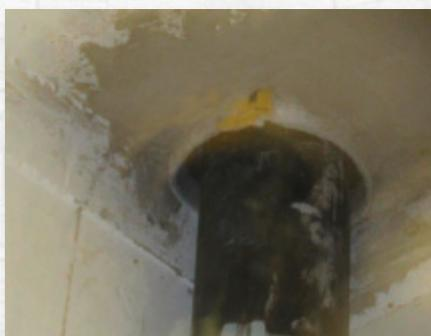
**Deckeneinbau:** für R90-Anforderungen bei Massivdecken stärker als 150 mm.
