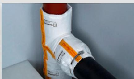
**Sicherer Übergang:** Gleich drei Varianten der R90-Mischinstallation löst unser AbZ geprüftes Brandschutzsystem sicher und praktikabel. Die BSM-GuKu ist für Installationsaufgaben am Materialübergang konzipiert.
