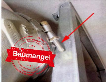
**Vorwand:** MSA würde hier vor ungewollten Kontakten der Abwasserleitung mit dem Baukörper wie z.B. über Trockenbauprofile schützen.
