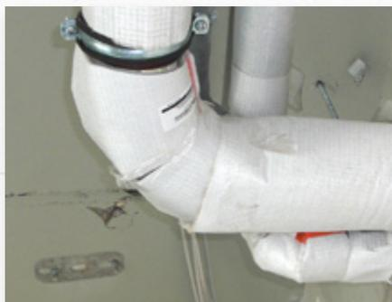
**Clever:** Formteile für Abzweige und Bögen ermöglichen lückenloses dämmen.
