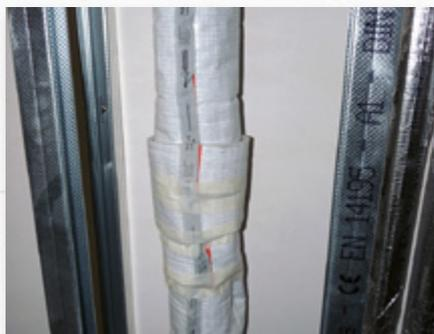
**Kombinierte Körper- und Luftschalldämmung:** Maximaler Schutz für Abwasserleitungen.
