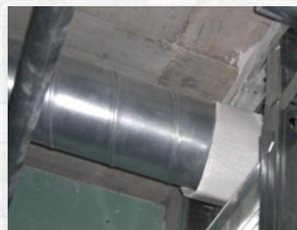
**Für raumabschließende Bauteile ohne Brandschutzklappen:** gilt bei Verwendung und Einbau von BSM-L.
