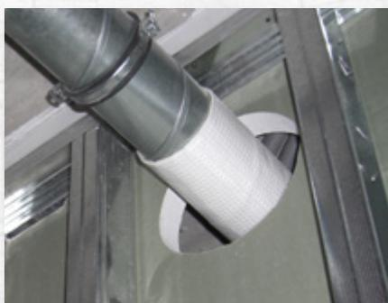
**BSM-L:** Die nahtverstärkte, reißfeste Manschette mit integriertem Schnellverschluss.
