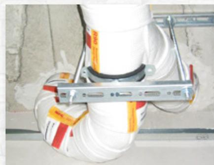
**R90 Ertüchtigung von Guss-Abwasserrohren:** Bis zu einem Rohrdurchmesser von 160 mm.
