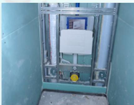
**Wichtig beim WC-Spülkastenelement:** Schwitzwasserdämmung der Versorgungsleitung.
