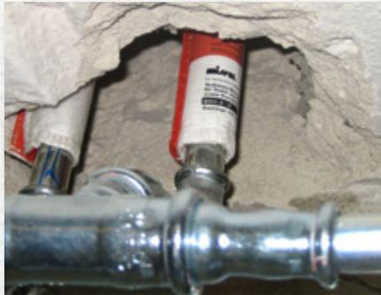
**Platzsparend:** Minimale Dämmdicke von 13 mm ermöglicht enge Kernbohrungen.
