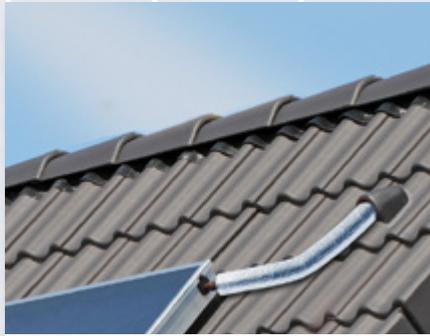
**Anschluss gefunden:** Einfach mit dem Kollektor verbunden – durch den Klemmring-Schnellverbinder.
