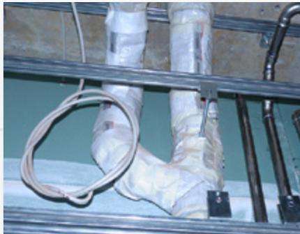
**Alternativ zu abgehängter Decke oder gemauertem Schacht:** Körper- und Luftschalldämmung.
