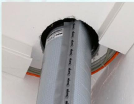
**Perfekt ausgestattet:** mit diffusionsdichter Selbstklebeausrüstung und integriertem Schnellverschluss.
