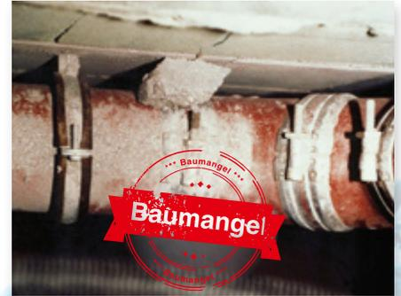
**Mörtel:** Ohne MSA werden z.B. durch herabfallenden Mörtel am ungedämmten Abwasserrohr akustische Probleme verursacht.
