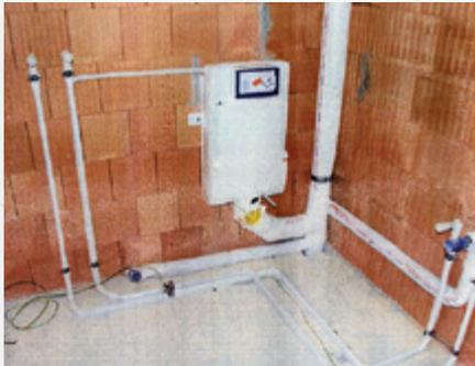
**Umfassend gedämmt:** Einbauelemente im Nassbau sicher vor Körperschallübertragungen schützen.
