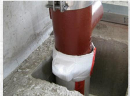
**Formstücke wie Verbinder:** Für Guss-Abwasserleitungen im Deckenverguss.
