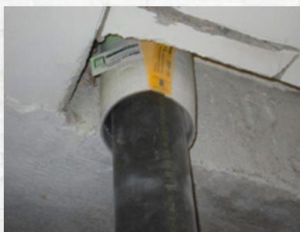
**Ohne Hilfsmittel:** für verschiedenste brennbare Abwasserleitungen einsetzbar.
