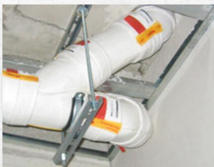
**Sichere Deckenmontage:** Auch mit MSA 4-R90 Formteilen in R90-Qualität.
