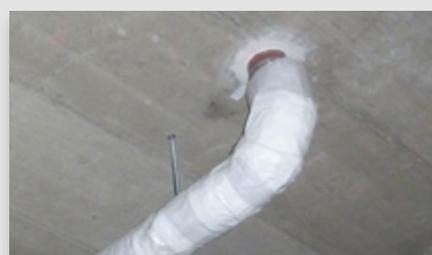
**Extrem flexibel:** MKB-Flex verklebt auch unebenes Dämmmaterial wie z.B. MSA 9-KL mit hoher Haftkraft. Spezialbereich ist die Verklebung von Formteilen, Handzuschnitten etc.
