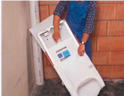
**Passgenau:** Das einteilige Formelement ist für die schnelle, werkzeuglose Montage geeignet.
