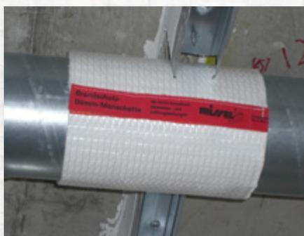
**Verschiebefähigkeit:** Mit der innenliegenden Gleitfolie entlang der Rohrachse.
