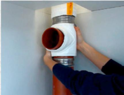
**Werkzeuglos:** Einfache und schnelle Montage per Schnellverschluss.
