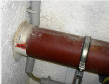
**Platzsparend:** Schmale Kernbohrungen durch geringe Dämmdicken.
