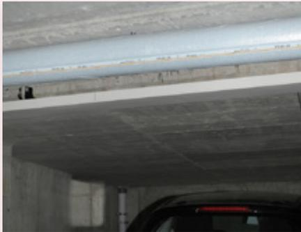
**Doppelte Dämmdicke:** Von Außenluft umströmte Rohrleitungen erfordern nach EnEV eine 200%-Dämmung.
