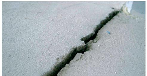
Verwölbungen und Absenkungen in den Fugenbereichen (bei Zementestrichen unvermeidbar!) treten bei Calciumsulfatestrichen auf Basis von Calciumsulfatbinder CAB 30 erst gar nicht auf.
