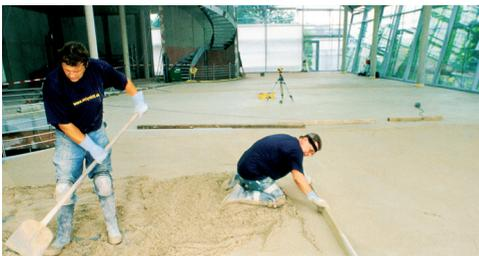
Calciumsulfatestriche auf Basis von Calciumsulfatbinder CAB 30 können großflächig fugenlos verlegt werden. Bauwerksfugen müssen im Estrich übernommen werden. Randfugen werden entsprechend der jeweiligen Estrichkonstruktion gem. DIN 18560 ausgebildet.
