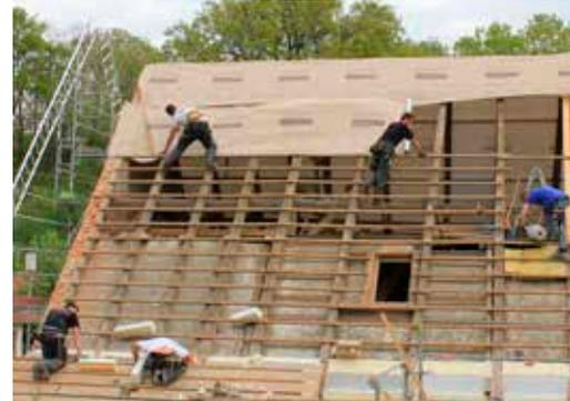
**1** Nach Entfernen der alten Dacheindeckung die LINITHERM L+D Folie aufbringen ...
