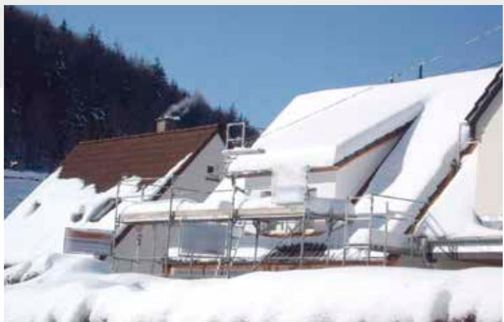
Der Winter bringt gute Dämmung an den Tag. Wo Schnee auf dem Dach liegen bleibt, ist gut gedämmt
