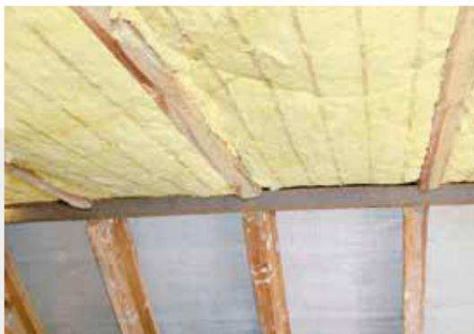
**3** | ... LINITHERM Dämmelemente mit integrierter Dampfsperre unter die Sparren schrauben und Fugen verspachteln ...
