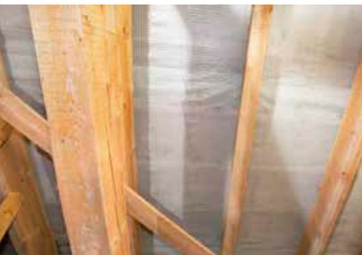
**2** | ... für eine schlanke Kombidämmung Mineralfaser im Zwischensparrenbereich einbringen. LINITHERM L+D-Pro Folie für die Luftdichtheit anbringen ...
