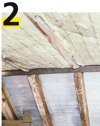
2 ... für eine schlanke Kombidämmung Mineralfaser im Zwischensparrenbereich einbringen. LINITHERM L+D-Pro Folie für die Luftdichtheit anbringen ...
