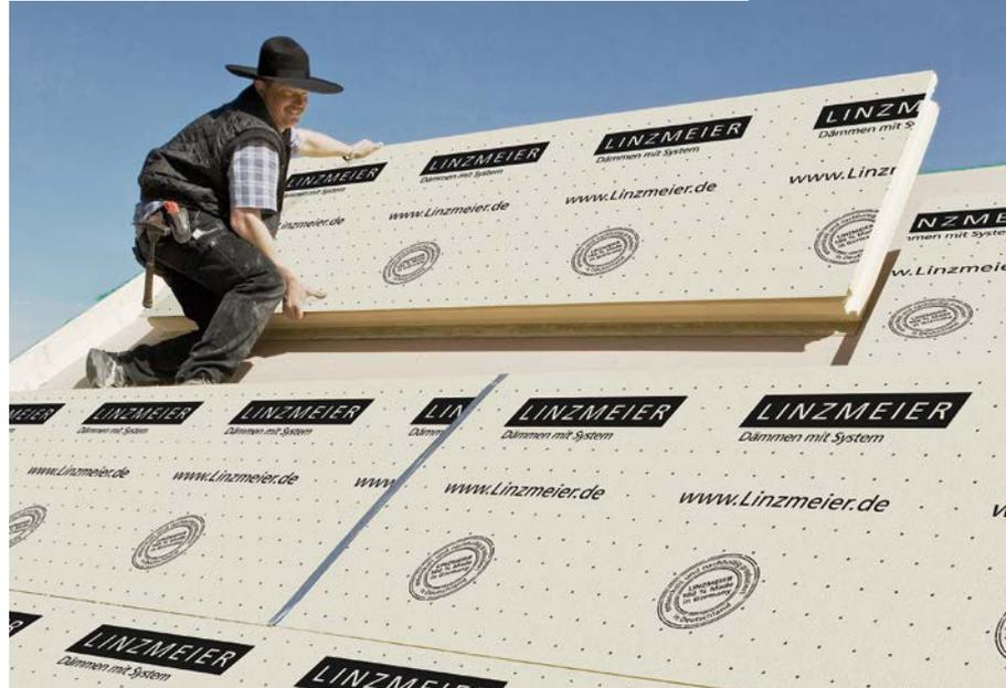
Die Dämmung auf den Sparren, also direkt unter den Dachziegeln.
