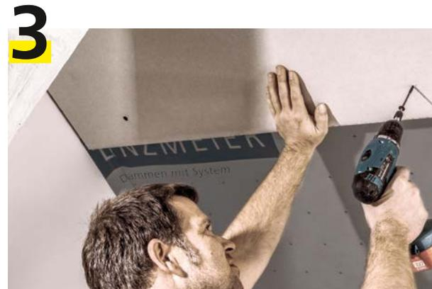
3 ... LINITHERM Dämmelemente unter die Sparren schrauben und Fugen verspachteln ...
