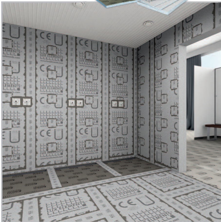
Duschbereich mit plattenförmiger Abdichtung
