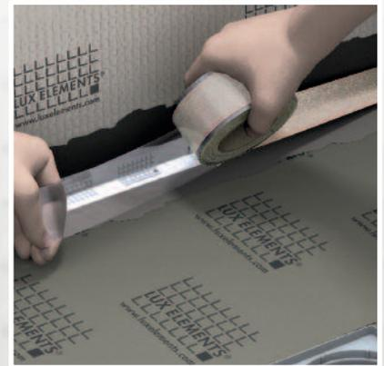
Zum Schutz der Abdichtung bei Erneuerung der dauerelastischen Wartungsfuge kann ein selbstklebendes Doppelgewebeband mit schnitthemmender Wirkung DRY-SB aufgebracht werden.
