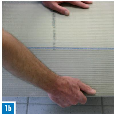
Bei geringeren Dicken (4 mm) reicht ein einziger Schnitt zum Zerteilen. Bei Dicken von 6 mm bis 20 mm) entlang des Schnitts knicken.
