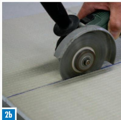
Den Winkelschleifer (segmentiertes Diamantschleifblatt) ansetzen und entlang der Schnittlinie durchschneiden (sehr leichte Schnittführung).
