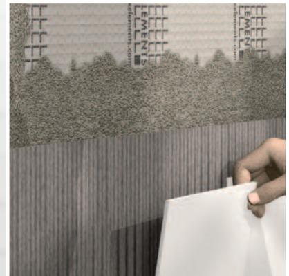
Fliesenverlegung im Dünnbettverfahren. Hierzu Fliesenkleber COL-FLEX mit Zahnpachtel vollflächig auftragen.
