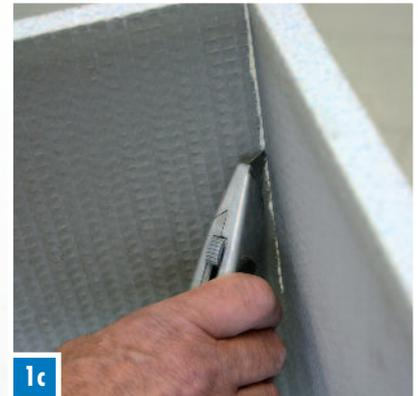
Anschließend im geknickten Zustand die rückseitige Mörtelschicht und das Glasfasergewebe mit dem Cutter durchtrennen.
