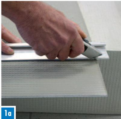
Mit Cutter an einem angelegten Lineal entlang einen durchgehenden Schnitt auf der Oberseite des Hartschaum-Trägerelements ausführen.
