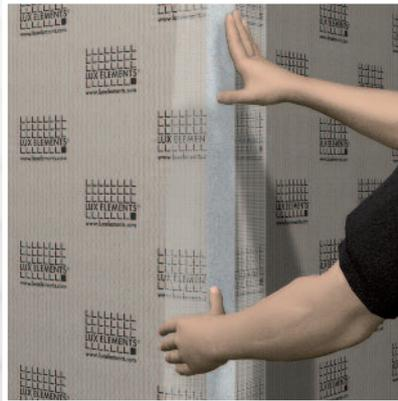
Für die Armierung von Ecken werden etwas breitere, selbstklebende Armierungstreifen ARM-150 SK oder ARM-250 SK eingesetzt und anschließend mit Ansetzkleber COL-AK abzuspachtelt.
