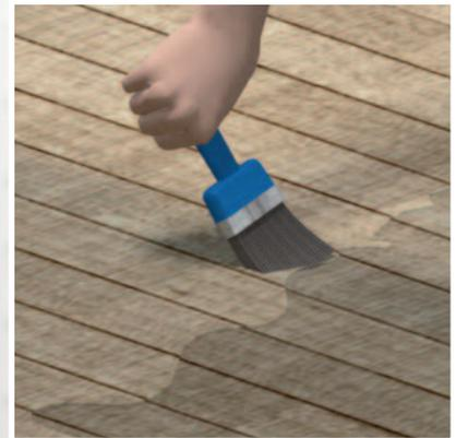
Als Haftvoranstrich für glatte, dichte oder saugende Untergründe empfiehlt sich eine dispersionsfreie Grundierung mittels COL-HSV.
