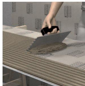
Bei Verwendung der ELEMENT-EL Baby 4 immer den Ansetzkleber COL-AK mittels Zahnpachtel vollflächig auftragen.
