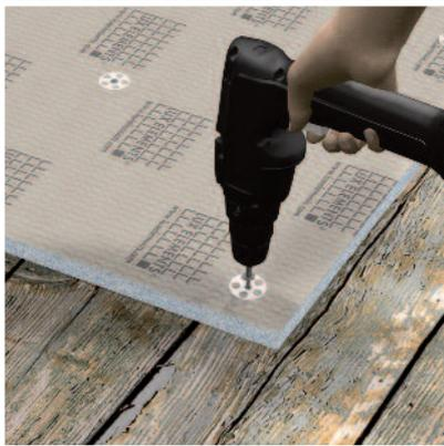
Hartschaum-Trägerelemente werden mit geeigneten Schrauben und entsprechenden Scheiben **FIX-S** auf Holzböden verschraubt.
