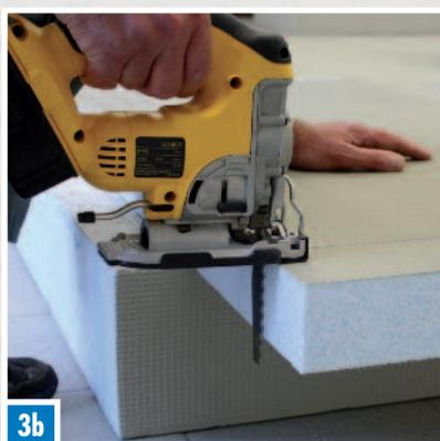
Vor dem eigentlichen Zuschnitt mit Stift und Lineal eine Schnittlinie einzeichnen. Anschließend mit der Stichsäge entlang der Linie zuschneiden (sehr leichte Schnittführung).
