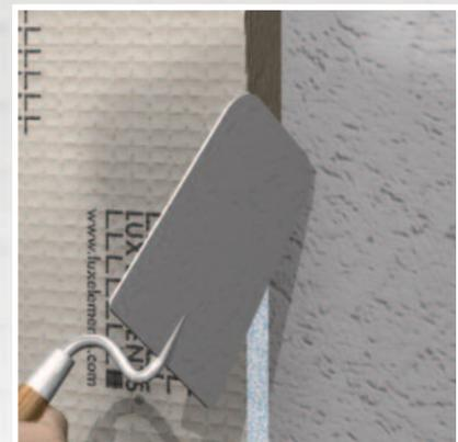
Zur Verklebung der Kanten, z.B. bei Stößen, Ansetzkleber COL-AK mit Kellenspachtel auftragen.
