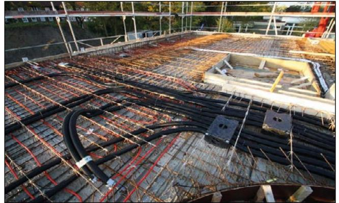
Werden Flexrohre in Decken mit Brandschutzanforderungen eingelegt, sind Mindestdicken der Decken bzw. oberhalb und unterhalb der Einbauten zu berücksichtigen. Die genaue Einbausituation ist anhand des Brandschutzkonzepts für das einzelne Gebäude mit der örtlichen Bauleitung zu klären. Siehe auch DIN 4102-4 3.4 Tabellen 9 und 10.
