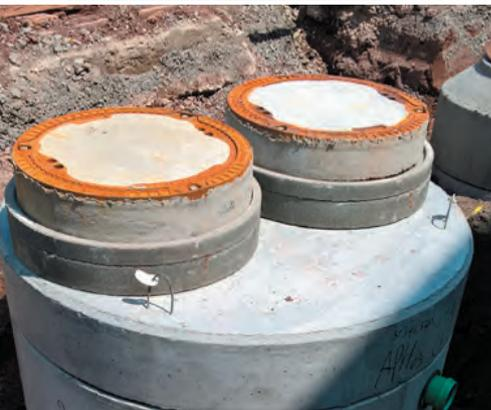
Zur Verbesserung der Versorgungssicherheit bauen die Stadtwerke Böblingen zwei Blockheizkraftwerke mit einer elektrischen Leistung von jeweils rund zwei Megawatt an unterschiedlichen Standorten innerhalb des Stadtgebiets. Nach der Fertigstellung sollen hier mit dem Einsatz von Erdgas kombiniert Strom und Wärme erzeugt werden. Für eventuelle Havarien musste eine Auffangmöglichkeit für austretende wassergefährdende Stoffe eingeplant werden.
