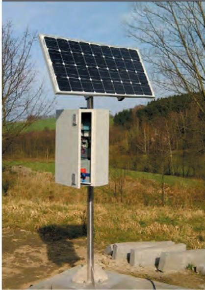
**NeutraSun ist eine selbsttätige solarbetriebene Warneinrichtung für ABKW-Abscheider und Abscheider nach DIN EN 858/DIN 1999-100 und eignet sich zur Überwachung an Standorten ohne zentrale Stromversorgung. Die bewährte Warneinrichtung NeutraStop Typ OAC mit integriertem GSM-Modem ist Bestandteil unserer Solarwarneinrichtung.**
