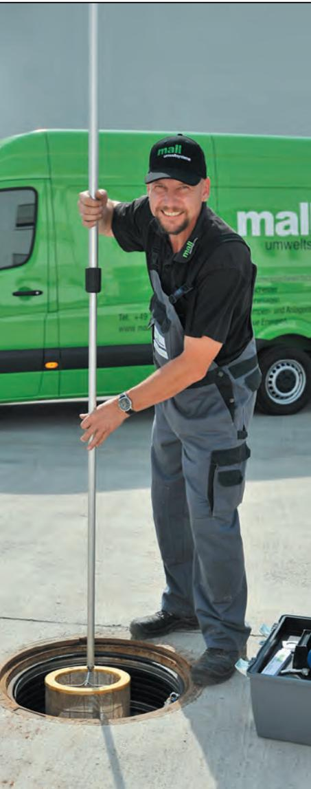
Eine wichtige Grundvoraussetzung für die dauerhafte, störungsfreie Funktion der Abscheideranlage sind regelmäßige Kontroll- und Wartungsarbeiten. Mit NeutraTool kann man diese fachgerecht durchführen. Wichtige Hinweise, Informationen und die erforderlichen Vordrucke beinhaltet die zugehörige Betriebsdokumentation (Betriebstagebuch).
