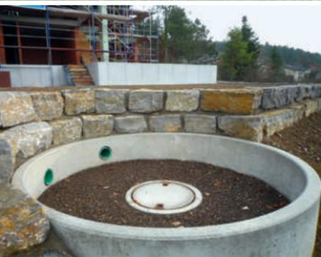
So schön kann Regenwassernutzung sein. Mit dem Mall-Terra-Regenspeicher wird die kombinierte Nutzung und Versickerung von Wasser nicht nur besonders einfach, sondern auch noch attraktiv, denn diese Anlage ist mit einer integrierten, belebten Bodenzone ausgestattet. In den meisten Fällen erfüllt das System die Kriterien der Erlaubnisfreiheit.
