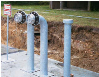
**Löschwasserbehälter sind unterirdische, überdeckte Speicher für die vom Trinkwassernetz unabhängige Versorgung mit einer oder mehreren Löschwasserentnahmestellen.**
