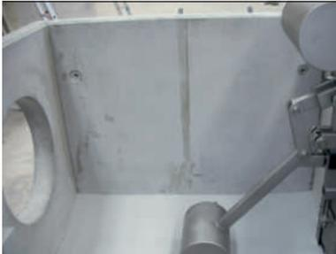
Die Drossleinrichtungen ViaPart regulieren die Zulaufmengen zu den Behandlungsanlagen. Die überschüssige Wassermenge muss im Drosselfall einen anderen, ausreichend dimensionierten Weg nehmen. Dieser Weg kann ein umlaufender Kanal (Bypass), oder ein Regenrückhaltebecken sein. Mit dieser neuen Produktlinie bieten wir gebrauchsfertige, werkseitig hergestellte Drosselbauwerke mit verschiedenen Abflussbegrenzern wie Abflussreglern, Wirbelventilen oder skalier-ten Drosselschiebern.
