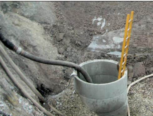
Gemäß DWA-A 138 werden Sickerschächte in einen Typ A und einen Typ B unterschieden.
