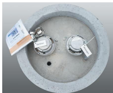
Füll- und Absaugstutzen Pelletspeicher
