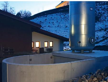
In der Gemeinde Kleines Wiesental im Landkreis Lörrach, im Südwesten des Schwarzwalds, bauen die Elektrizitätswerke Schönau die schon bestehenden Wärmenetze weiter aus. Im Ortsteil Neuenweg planten die EWS ein dörfliches Wärmenetz mit Hackschnitzeln und Solarthermie als Energie lieferanten, an das 25 Gebäude angeschlossen werden können. Dafür wurde eine Zentrale mit Hackschnitzel- und Ölkessel erstellt.
