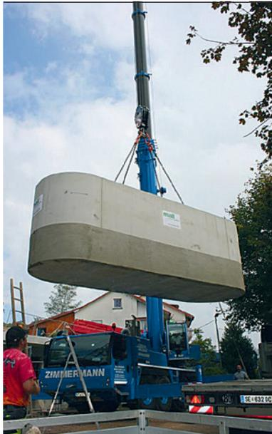
Der Pelletspeicher im monolithischen Ovalbehälter bietet bei einem Lagervolumen von 30 m<sup>3</sup> Platz für insgesamt 19,5 Tonnen Pellets. Auch hier kommt das automatische Entnahmesystem Maulwurf 6000 – E3 zum Einsatz.
