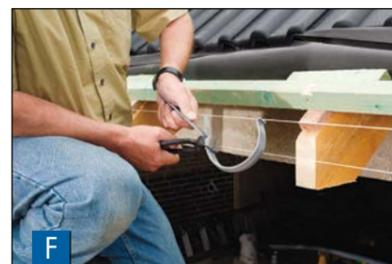
**F** Vor der Befestigung müssen die Rinneneisen abgebogen werden. Das Abbiegen geht am einfachsten mit einer großen Kneifzange, wie im Bild dargestellt, oder im Schraubstock.
