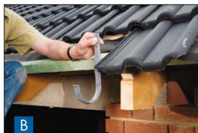
**B** Das erste Rinneneisen an dem Dachstein ausrichten: Die Vorderkante des Dachsteins muss  $\frac{1}{8}$  in die Rinne hineinstehen. Das letzte Rinneneisen mit **2 bis 3 cm Gefälle** auf 10 m montieren.
