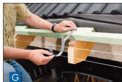
**G** Die abgebogenen Rinneneisen in den Aussparungen an der Dachlatte mit Spaxschrauben oder entsprechenden Nägeln befestigen. Tipp: Stirnbrett bei zu großen Sparrenabständen benutzen!
