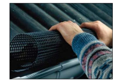
Poly-Net Laubstop-Gitterrohr wird in die Dachrinne eingelegt und klemmt sich durch seine Eigenspannung fest. Leicht zu verarbeiten, da Marley Poly-Net Laubstop in Längen von 2,00 m geliefert wird.
