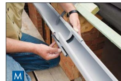
**M** Die Verbindungsschale wird über die hintere Abkantung eingehängt und über den vorderen Wulst geklippt. Markierungen beachten – Nocke-Nut-System!
