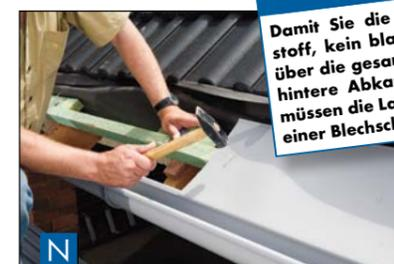
**N** Die Traufstreifen bieten zusätzlichen Schutz vor Regenwasser und Flugschnee. Sie werden in die Abkantung der Dachrinne eingehängt und mit Pappstiften alle 30 cm auf der Dachlatte festgenagelt. Traufstreifen werden mit einer Überlappung von mindestens 4 cm verlegt.
