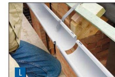
**L** Die Rinnen werden mit einer Verbindungsschale zusammengesteckt. Der richtige Abstand der Rinnenenden ergibt sich aus den Markierungen auf der Verbindungsschale. Wichtig: Bei gekürzter Rinne muss die Nut eingearbeitet werden.
