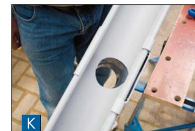
**K** Die Sägekante entgraten und den Rinnenstutzen über die hintere Abkantung einhängen und über den vorderen Wulst klippen.
