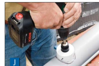
**J** Das Ausschneiden des Ablaufloches geht schnell und sauber mit einem Lochsägeaufsatz oder einer feinzahnigen Säge.
