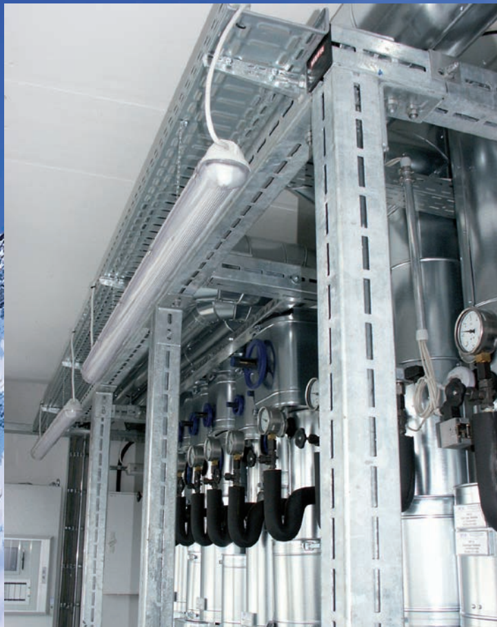
Technikraum CENTUM® Schwerlastsystem mit Anbauteilen
