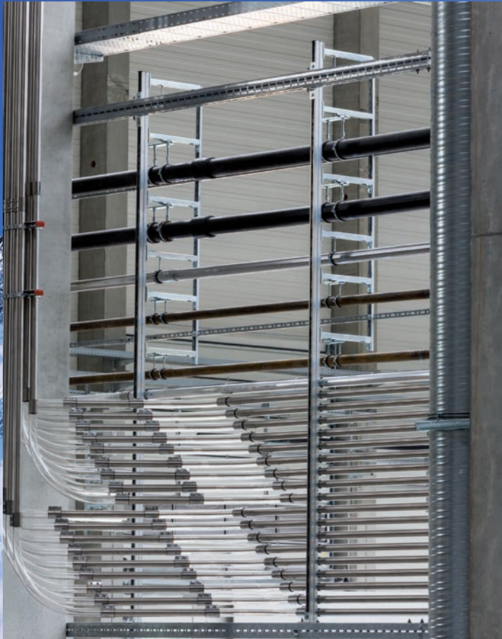
Mehrgeschossige Wandausleger und Festpunkthalterung HV Montageschienen System 45 und CENTUM®
