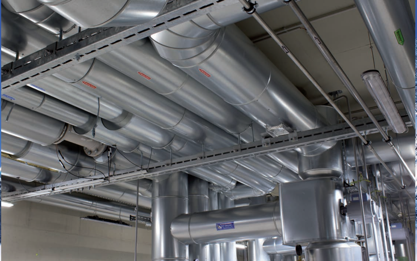
Deckenbefestigung für Heizungsrohrleitungen CENTUM® Schwerlastsystem
