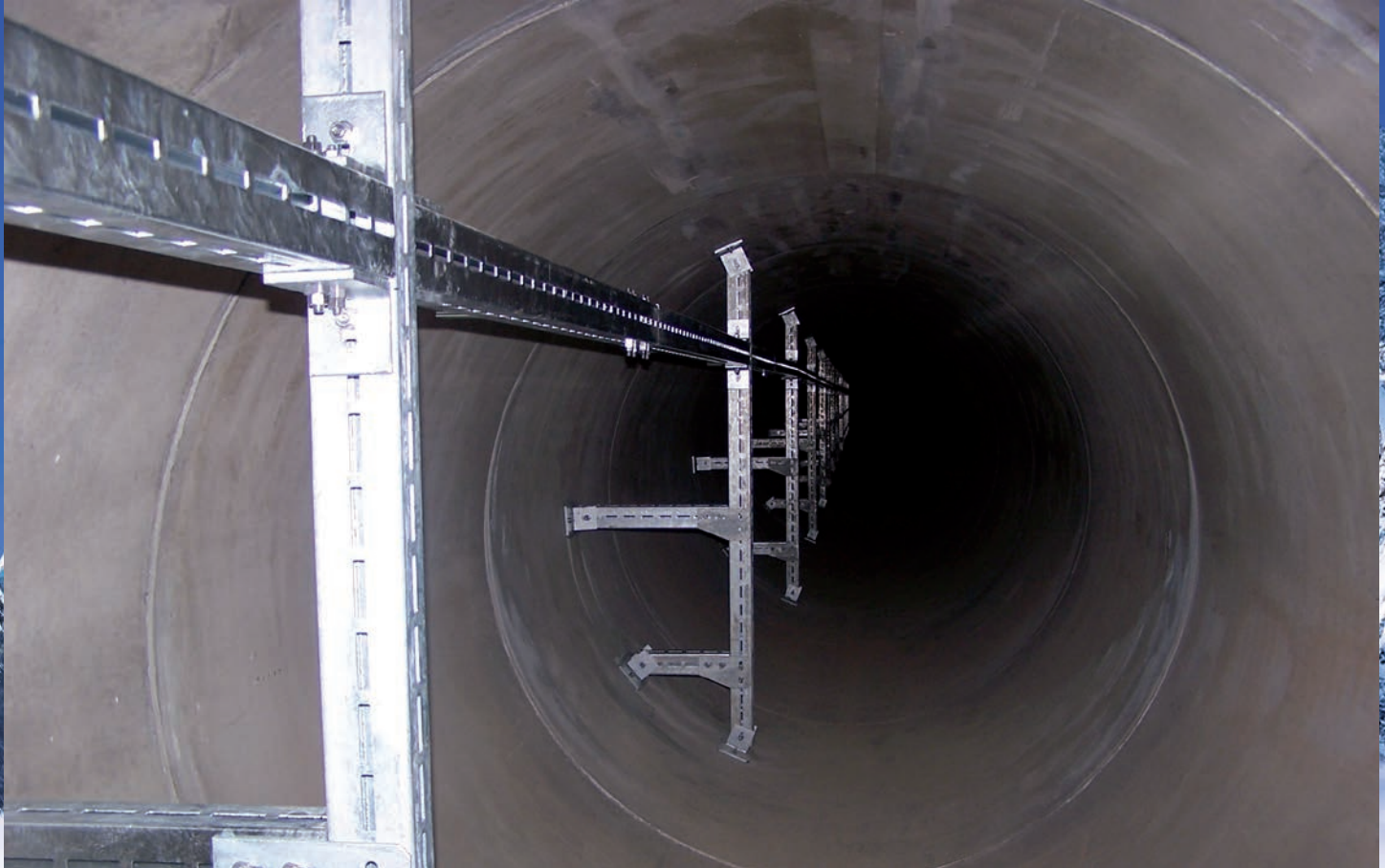
Halterungskonstruktionen an runder Tunnelwand Schwerlastsystem CENTUM® XL 100
