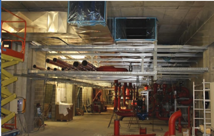
Deckenhalterung für Rohr- und Lüftungstrasse Montageschienen System 45 und CENTUM®
