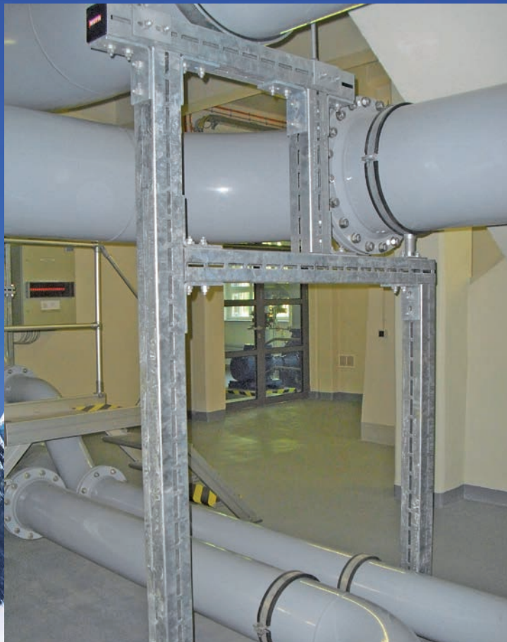
Wasserversorgungsleitung CENTUM® System mit Titan HD Rohrschellen
