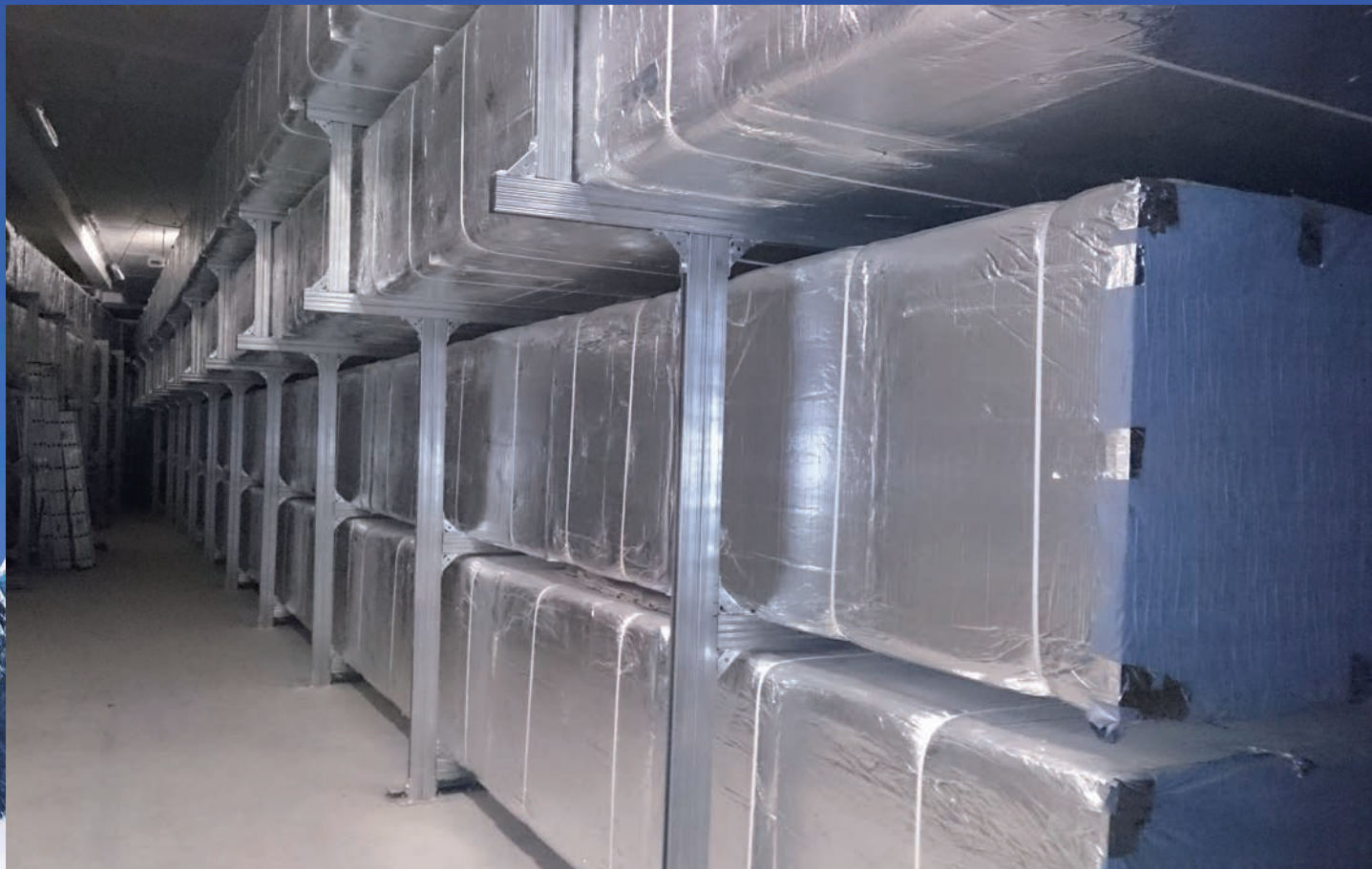
Lüftungssystem Montageschienen System 45 mit Anbauteilen
