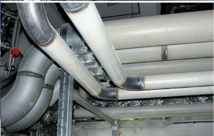
Kälteleitungen CENTUM® Schwerlastsystem mit Kältegleitschlitten
