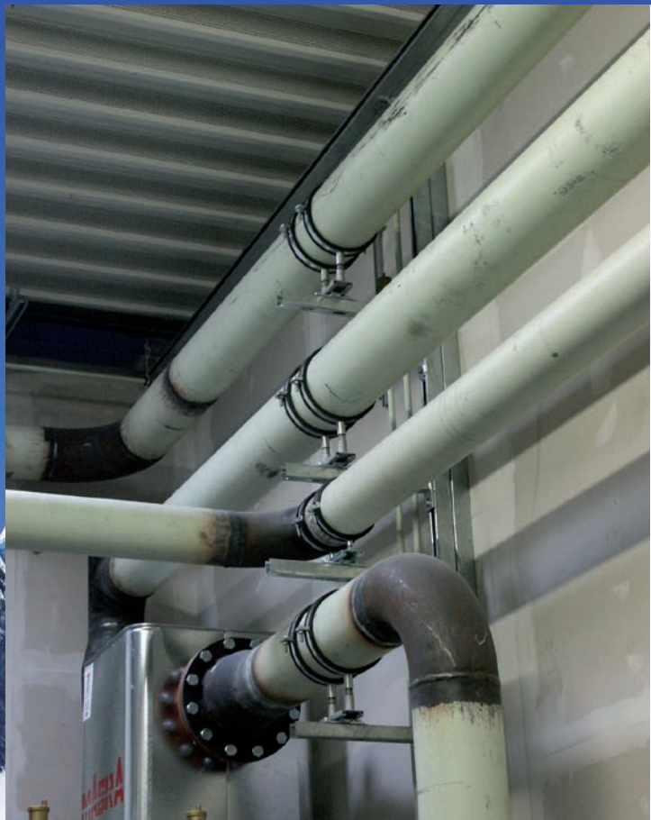
Produktionsanlage Härterei Montageschienen System 45 mit Konsolen
