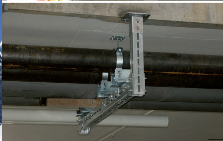
Heizungs- und Versorgungstrasse an Betondecke CENTUM® Schwerlastsystem mit Sonderlösungen
