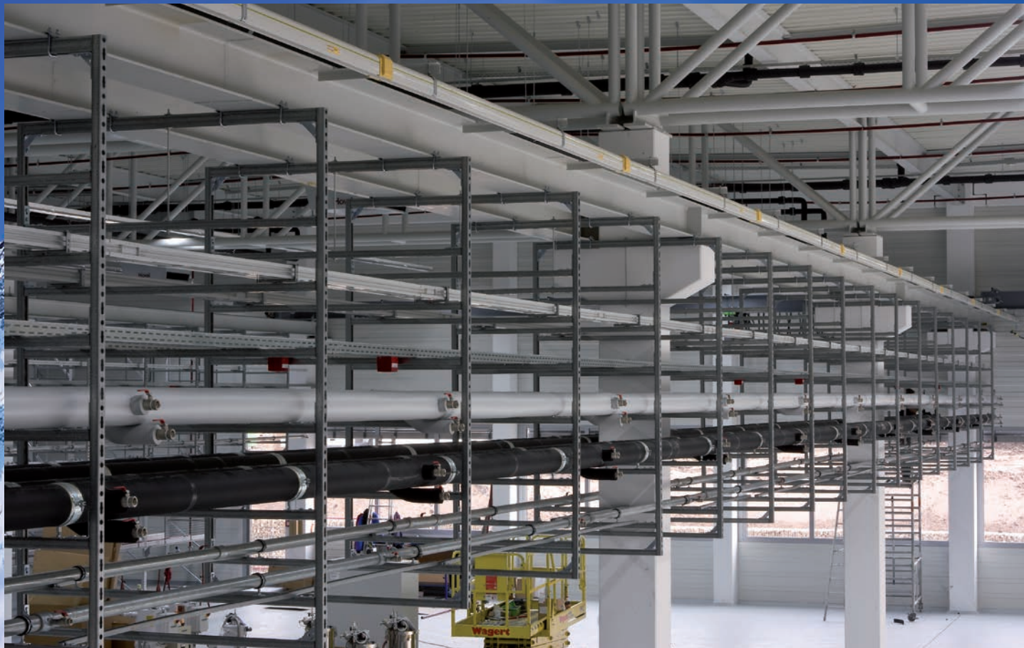
Abhängung an Stahlträgerkonstruktion Montageschienen System 45 mit Verbindungsbauteilen
