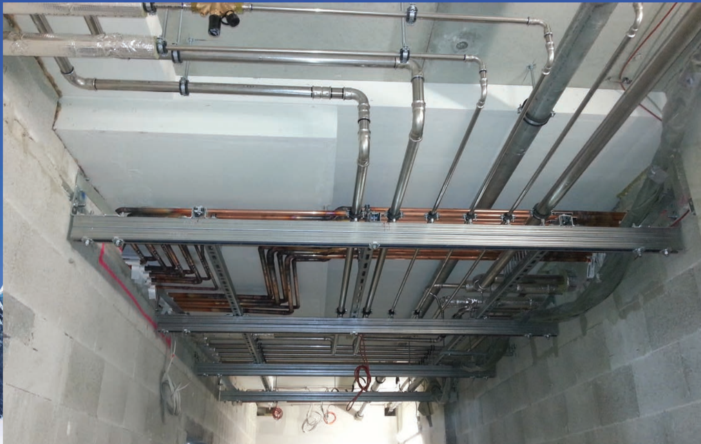
Quertraverse für Heizungsleitungen Montageschienen System 45/90
