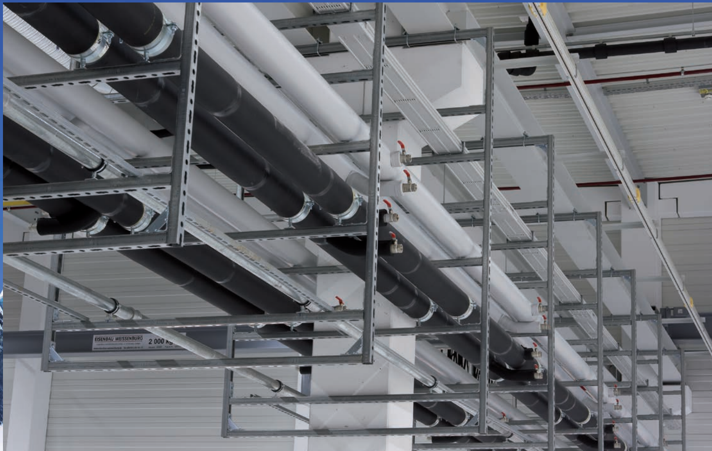
Abhängung an Stahlträgerkonstruktion Montageschienen System 45 mit Verbindungsbauteilen
