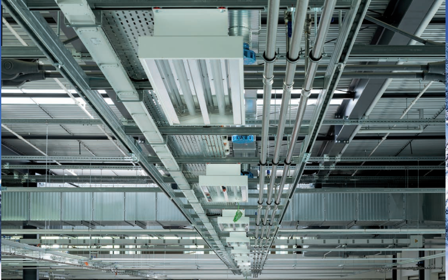
Schienenraster für Deckenrohrmontage Montageschienen System 45 und CENTUM®
