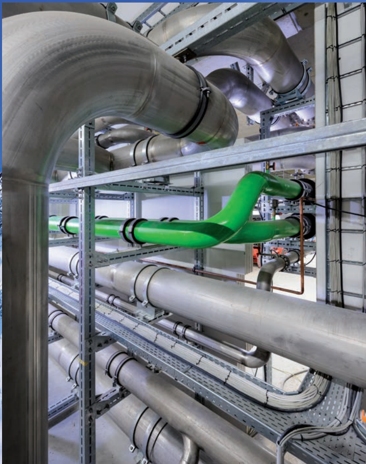
Kühlwasserleitungen CENTUM® Schwerlastsystem mit Anbauteilen
