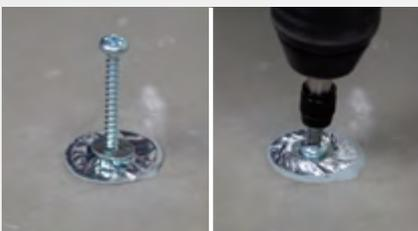
Dieses fest an den Untergrund drücken. Drehe die Schraube ein wenig mit der Hand an. Dann die Schraube fest anziehen.
